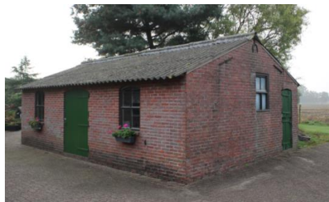
Afbeelding 20: te slopen externe berging
