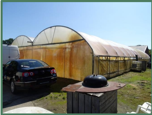
Buitenzijde te slopen windtunnels
