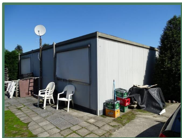
Achterzijde te slopen woonunits
