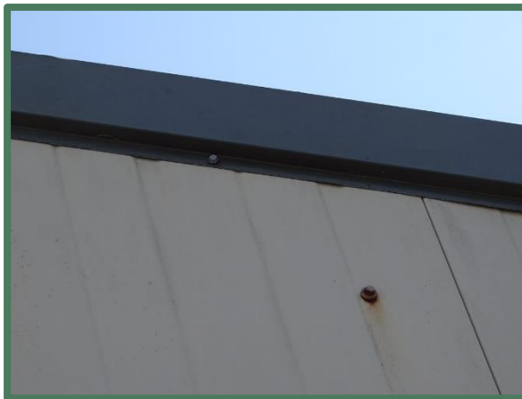
Strak aansluitend boeiboord op de gevel van de uit te breiden loods
