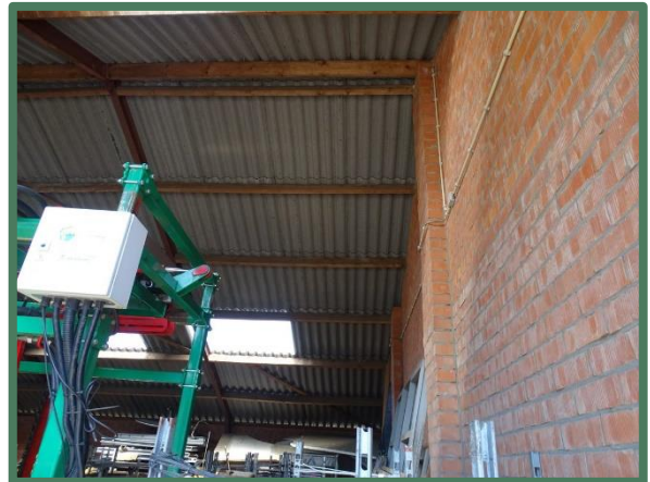
Binnenzijde te slopen loods
