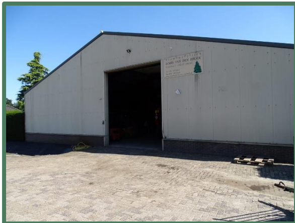
Wand en gevel aan het uit te breiden deel van de loods
