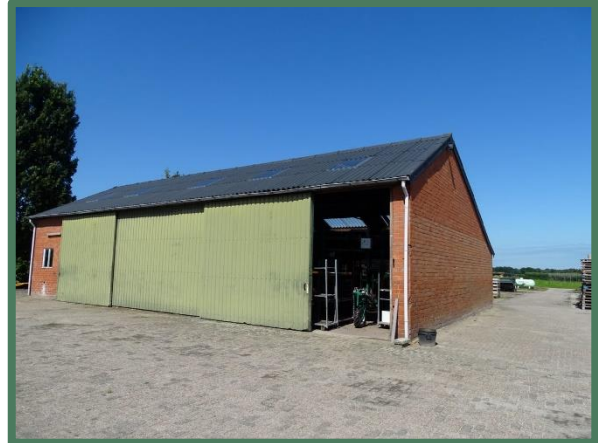
Rechterzijde te slopen loods
