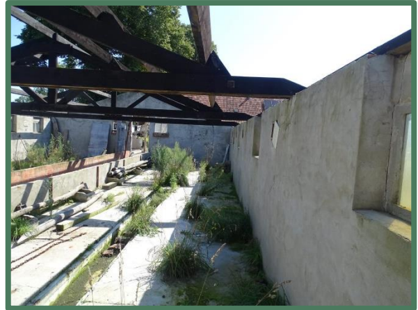
Binnenzijde varkensstal west
