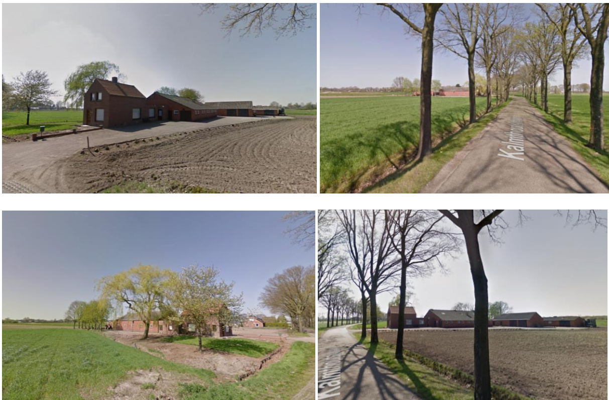
Figuur 4: Foto's van de bestaande bebouwing
