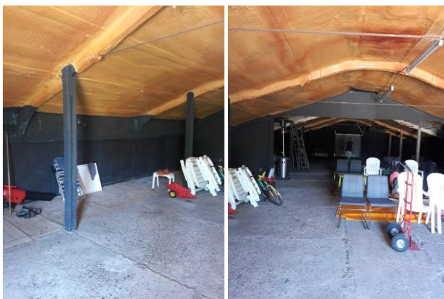
Figuur 14: Foto's schuur
