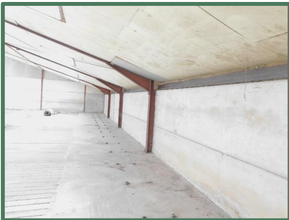
Zijgevel binnenzijde te slopen stal
