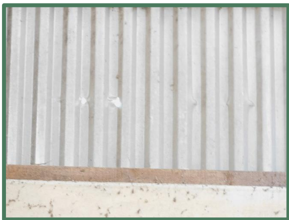
Kopgevel met damwand op muurplaat
