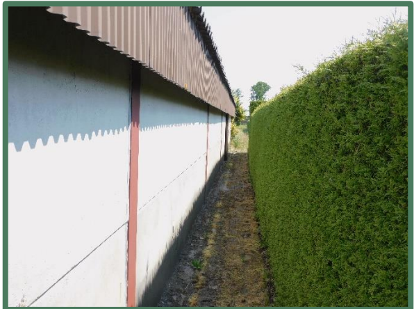
Zuidelijke gevel te slopen stal met te behouden haag
