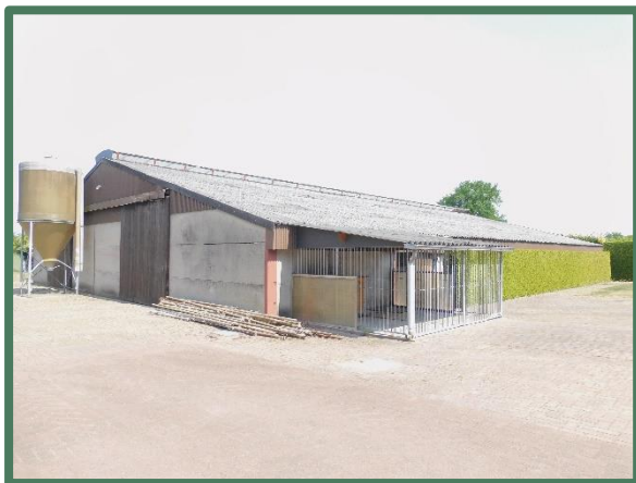
Te slopen stal vanaf west
