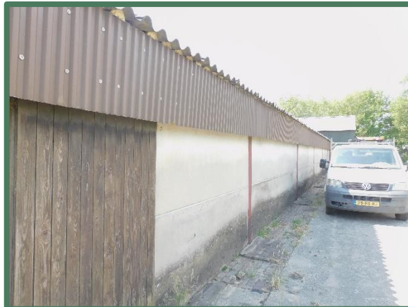
Noordelijke zijgevel te slopen stal
