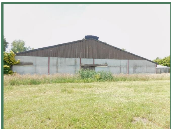
Oostelijke kopgevel te slopen stal
