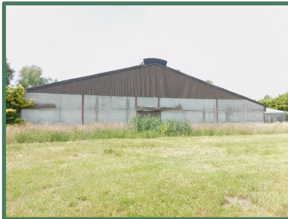
Oostelijke kopgevel te slopen stal
