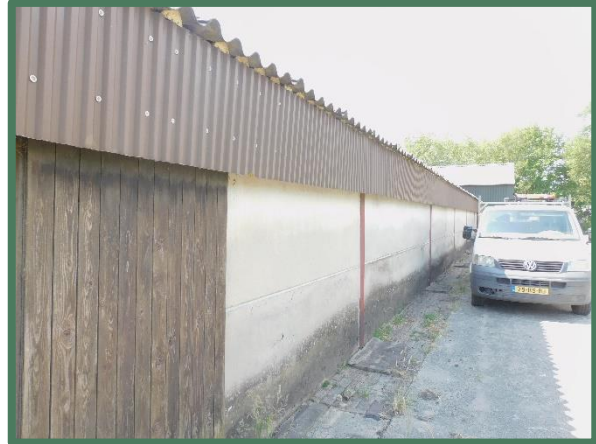
Noordelijke zijgevel te slopen stal
