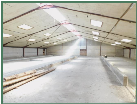
Binnenzijde te slopen stal
