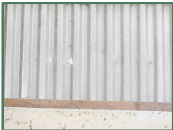
Kopgevel met damwand op muurplaat
