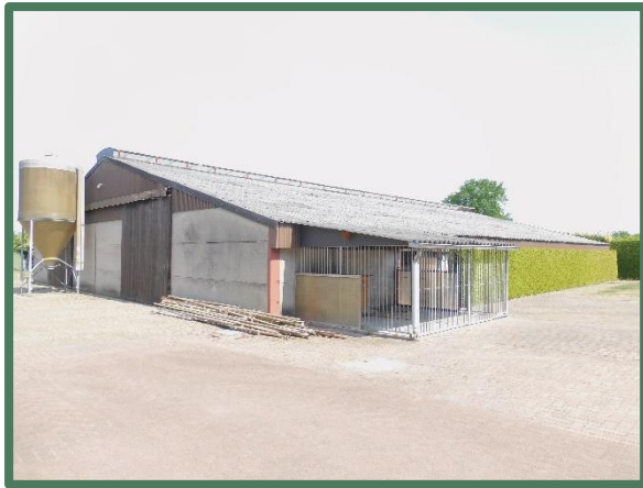
Te slopen stal vanaf west
