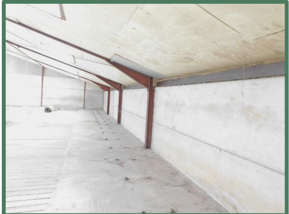
Zijgevel binnenzijde te slopen stal
