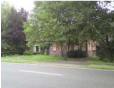
Voorgevel van de te vervangen langgevelboerderij
