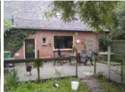
Terras achter de langgevelboerderij
