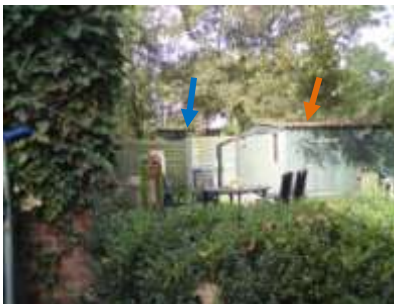
Houten schuurtjes met asbesthoudende golfplaten dakbedekking → vml. schaphok, → vml. kippenhok
