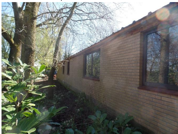
Zijgevel van aanbouw
