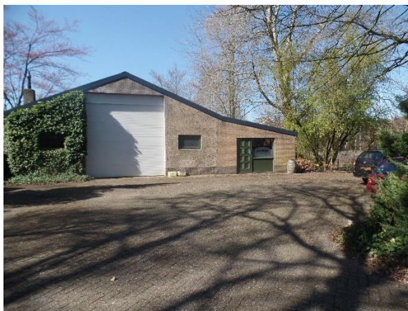
Schoor met de te slopen aanbouw.
