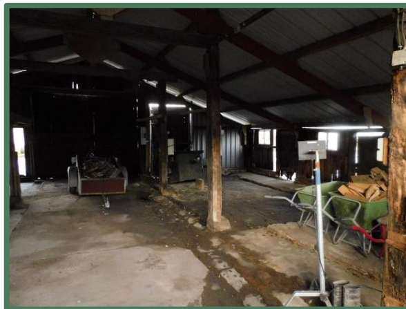
Binnenzijde te slopen schuur
