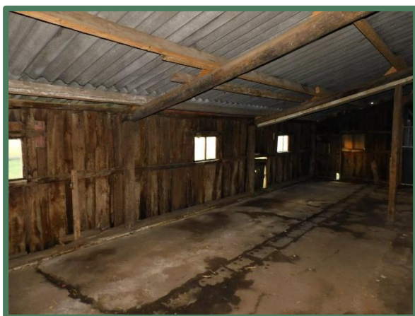
Binnenzijde te slopen aanbouw
