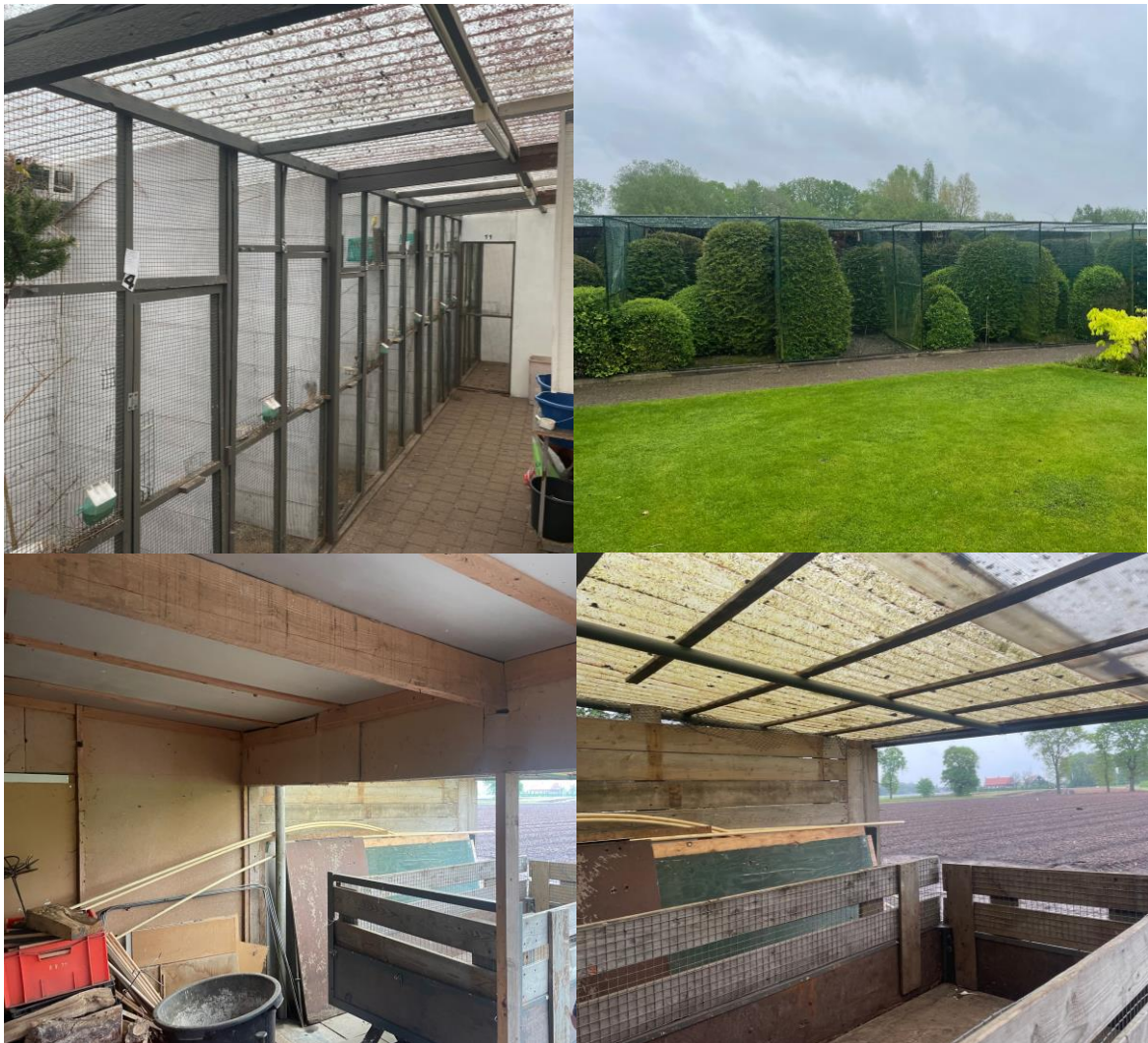
Figuur 16: Foto's te slopen gebouwen
