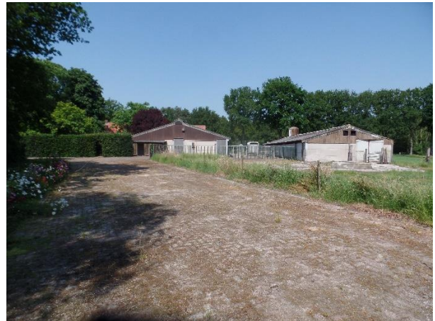
Zicht op beide schuren vanuit oostelijke richting
