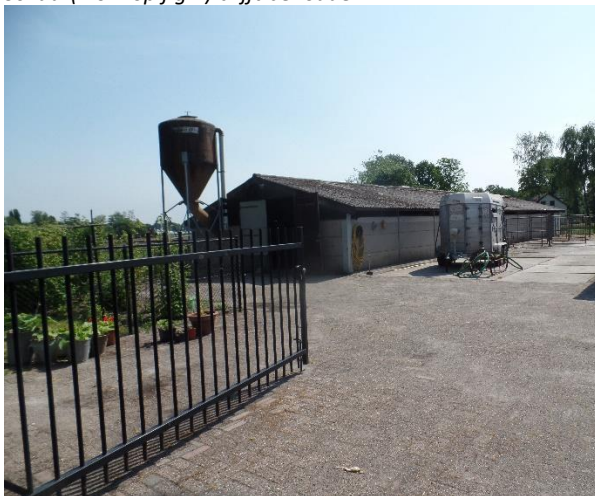
Schuur (no.3 op fig.2) wordt gesloopt
