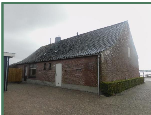
Overzicht te slopen woning vanaf noord
