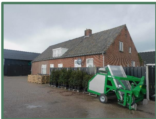
Overzicht te slopen woning vanaf zuid
