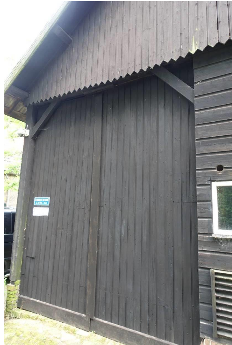
Oorspronkelijke deeldeuren, geheel links in de voorgevel.
