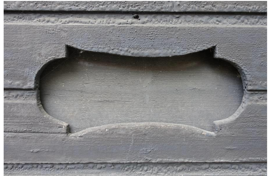
Detail van één van de licht- en ventilatieopeningen in de linker zijgevel.
