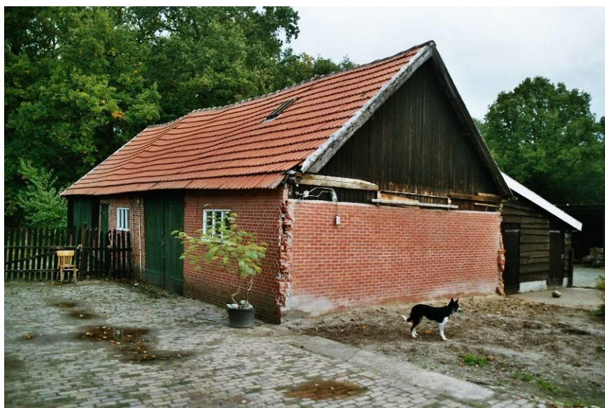
De eerder aan de oostzijde aangebouwde garage is nu gesloopt. Bron: BBA.
