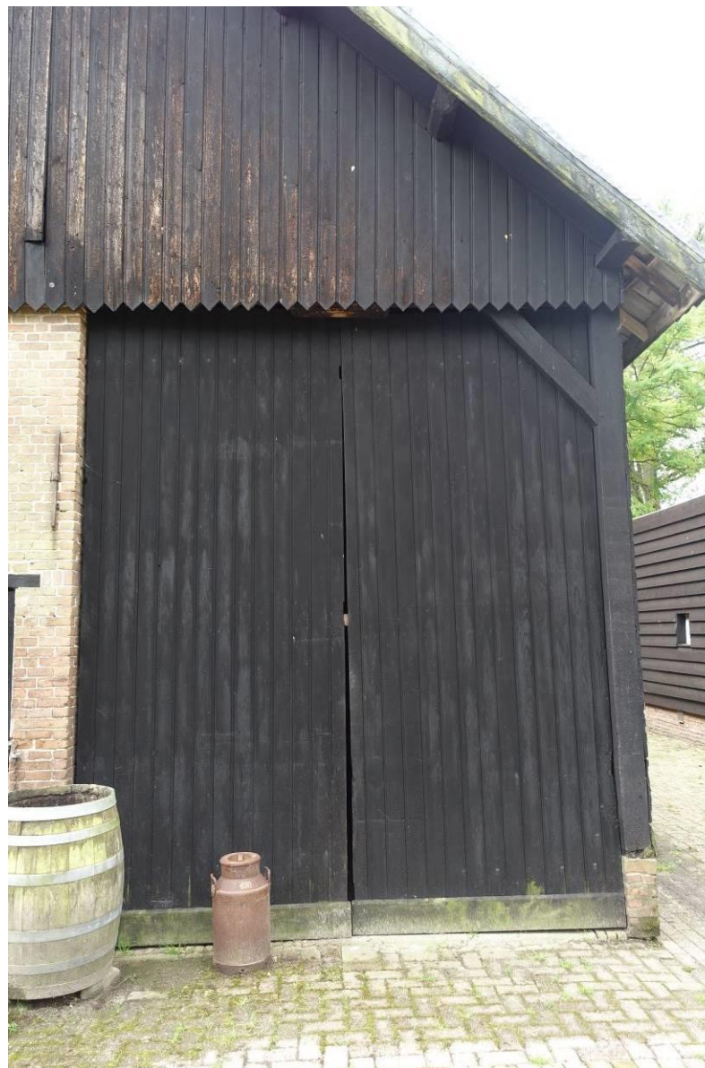
De rechts in de achtergevel aanwezige oorspronkelijke deeldeuren.
