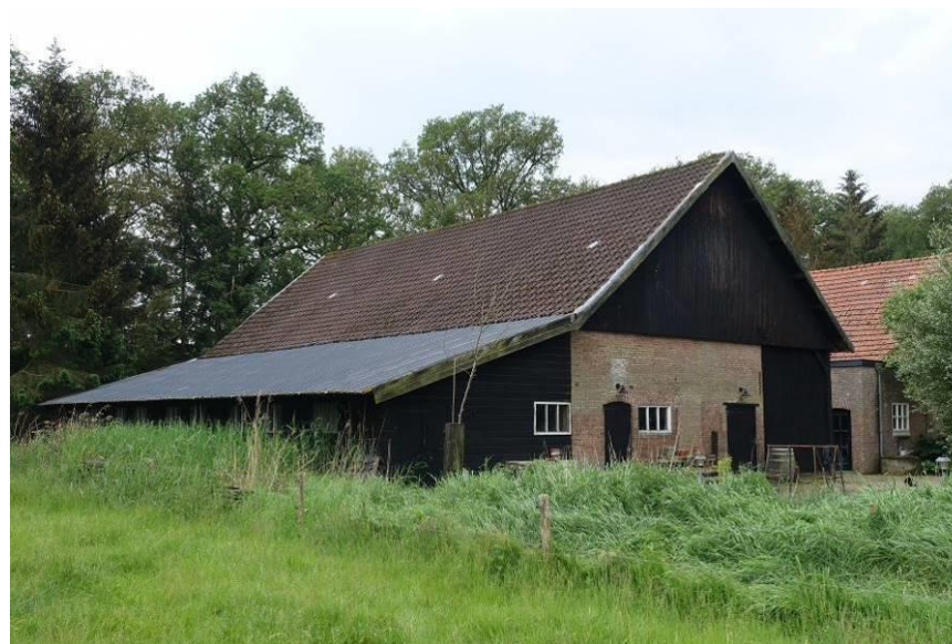
Overzicht van de schuur uit het noordoosten.
