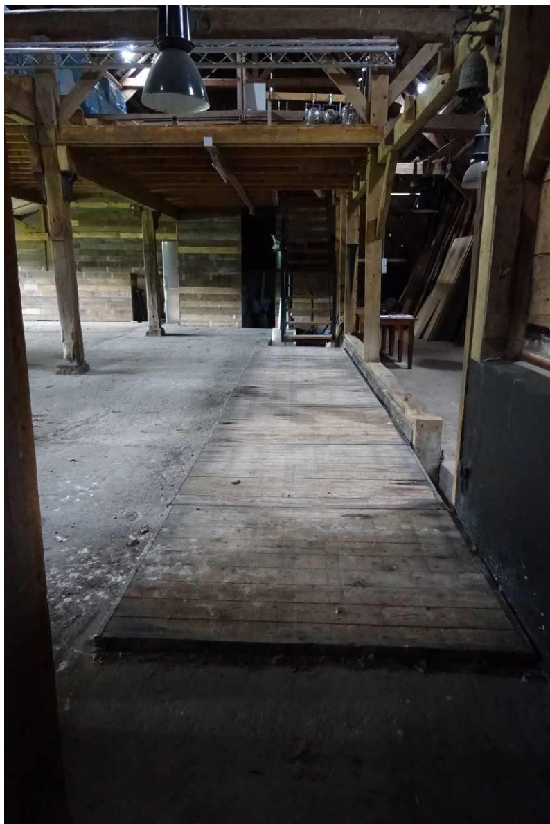
Zicht vanaf de vroegere paardenstal richting de voorgevel, met op de achtergrond de later ingevoegde verdieping.
