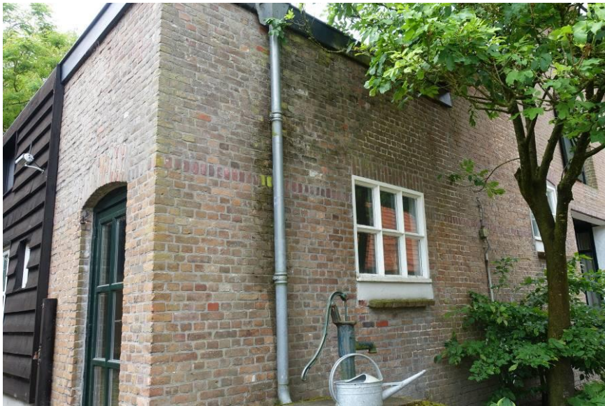
De achtergevel van de uitbouw. Hier is goed zichtbaar dat deze uitbouw werd verhoogd.
