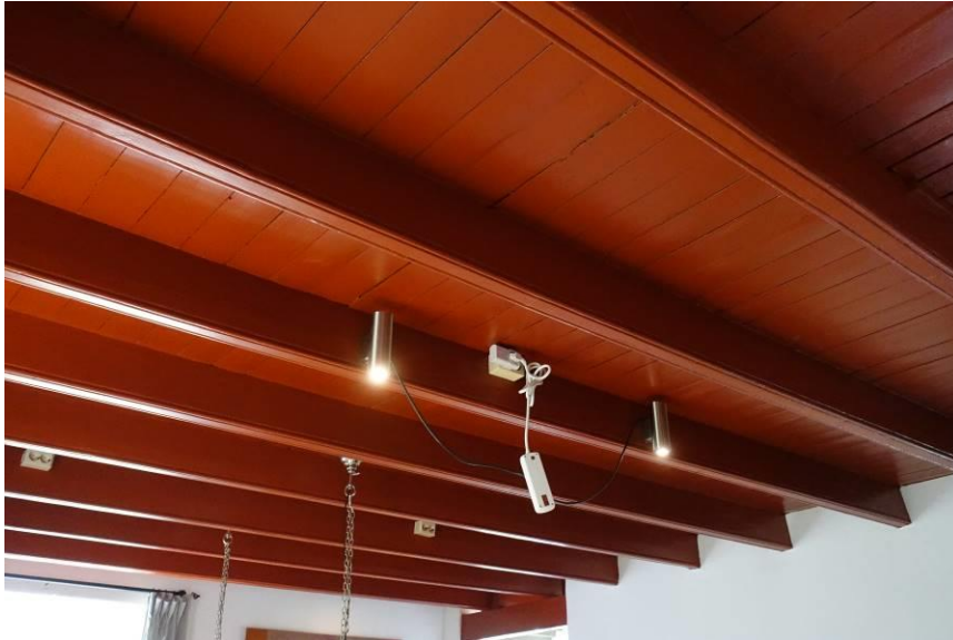
Overzicht enkelvoudige verdiepingsbalklaag boven het rechter deel van het voormalige woongedeelte.
