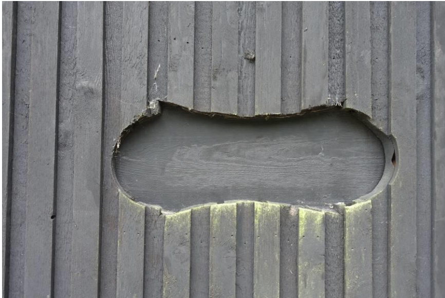
Detail van één van de ventilatieopeningen naar voorbeeld van de openingen in de grote schuur.
