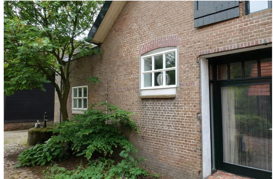
Linker deel van de achtergevel. De betonnen ramen werden later ingevoegd ter vervanging van de oorspronkelijke vensters.
