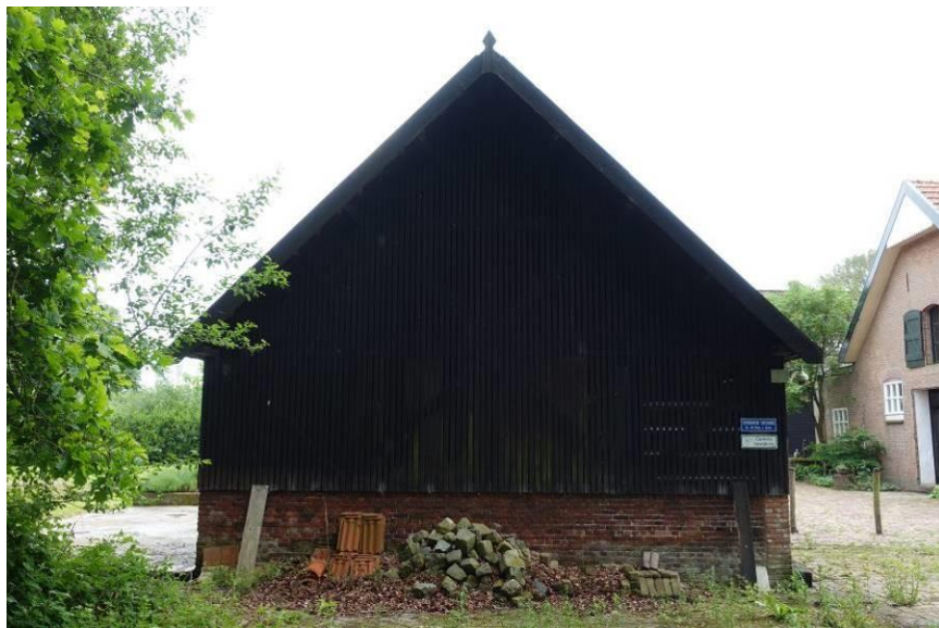
Overzicht van de westgevel.
