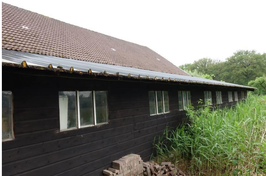
Overzicht van de tot de uitbreiding behorende rechter zijgevel.
