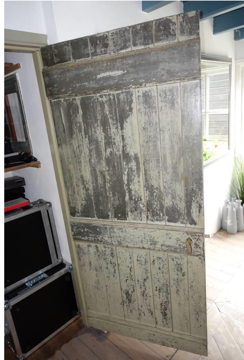
Oorspronkelijke opgeklampte deur van de plee.
