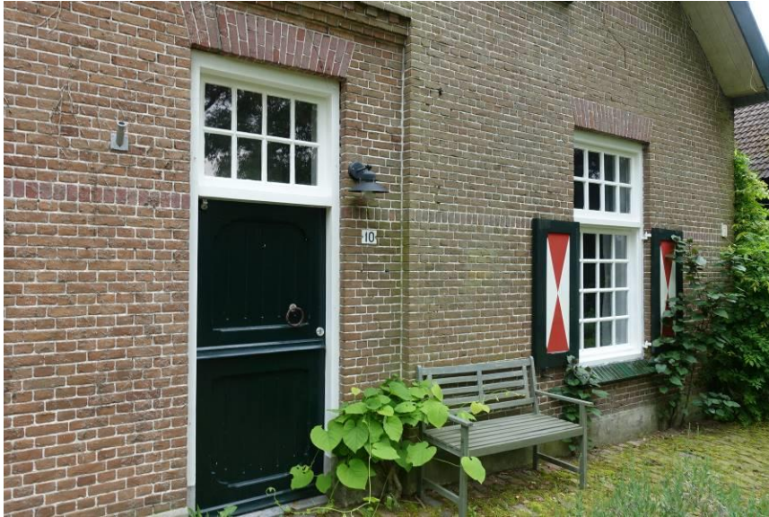
Rechter zijde van de begane grond van de voorgevel.
