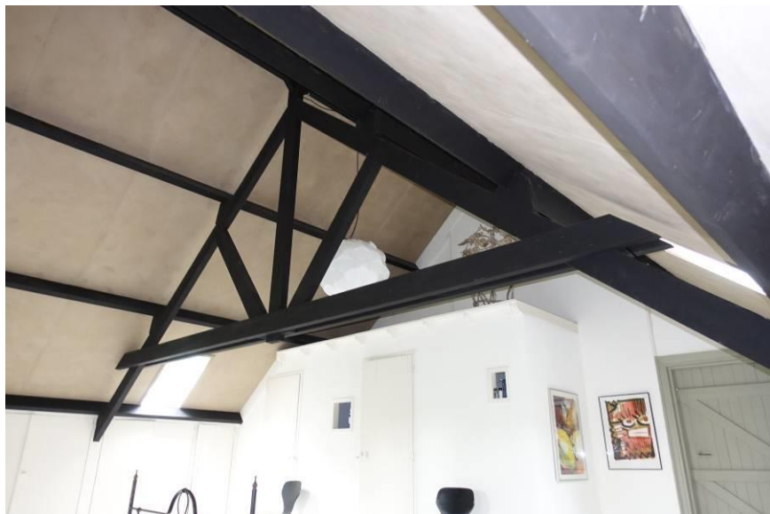
Overzicht van de voorste ruimte op de verdieping, richting de brandmuur. Links tegen de brandmuur de ingevoegde cv-ruimte en badkamer.
