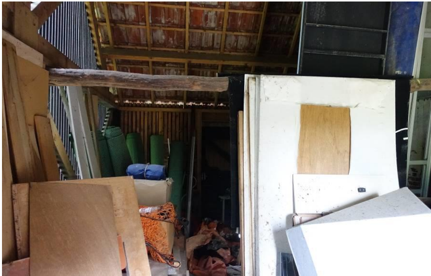
Overzicht van de westelijke ruimte in noordelijke richting, met de oudere rondhouten balk tussen de westgevel en de rechter zijwand.
