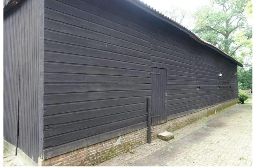
Overzicht van de linker zijgevel.
