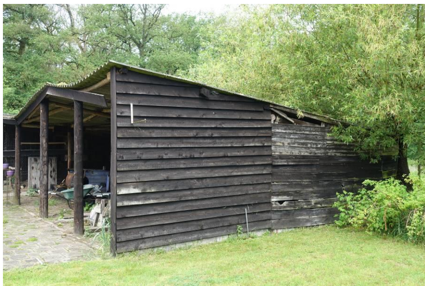
De oostgevel van de loods.
