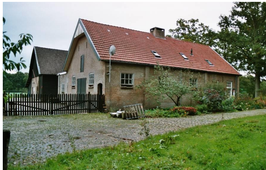
Westzijde van het erf met een toegang vanaf de boslaan en hekwerk tussen de boerderij en de varkensschuur. Bron: BBA.
