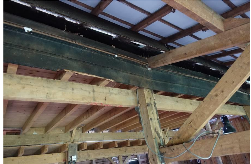
Bij de aansluiting van de constructie van de uitbreiding zijn nog enkele delen van de oorspronkelijke oostgevel bewaard gebleven.
