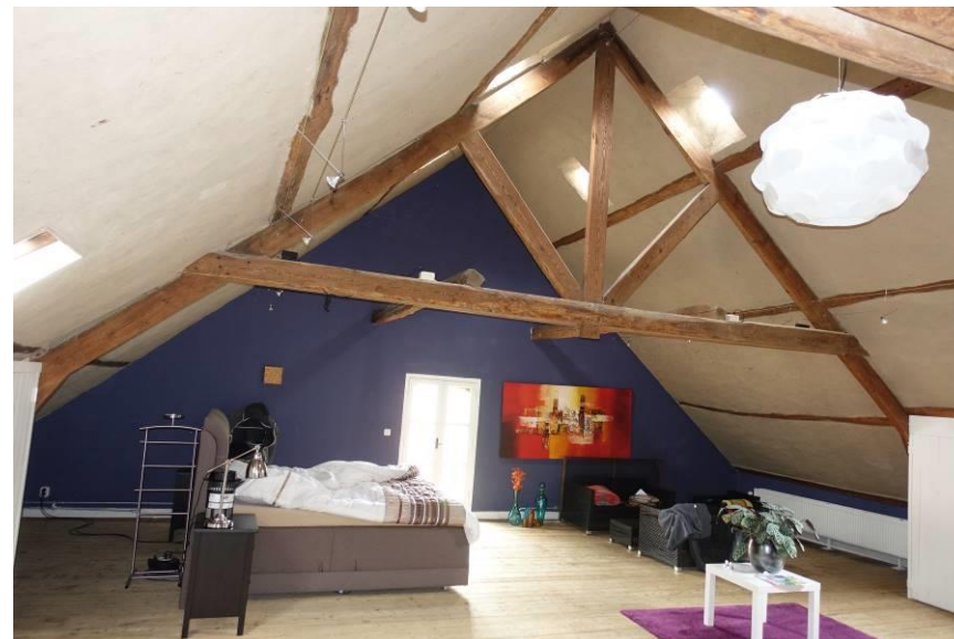
Overzicht van de achterste ruimte op de verdieping, richting de achtergevel.
