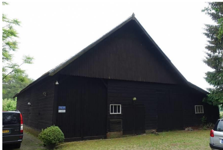
Overzicht van de schuur uit het zuiden.
