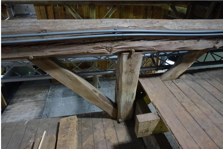
Bovenzijde van één van de stijlen van de gebinten.
