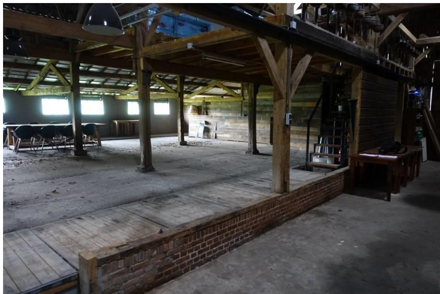
Langs de deel staan de kolommen op een lage voetsmuur met muurplaat.
