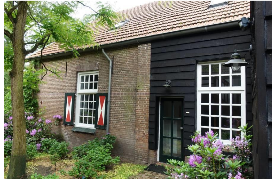
Overzicht van het naast de uitbouw zichtbare zijgevel van het hoofdvolume.
