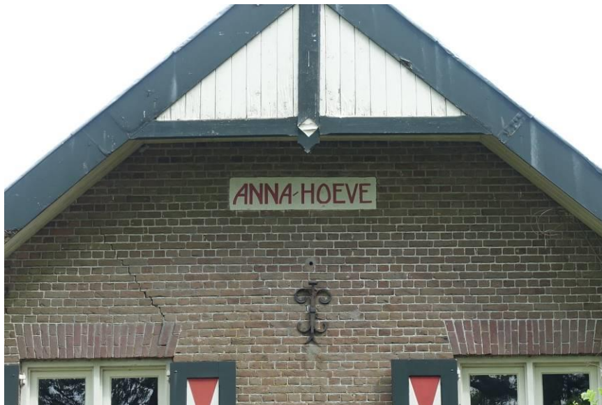
Detail van de bovenzijde van de voorgevel met de naam onder het overstek.
