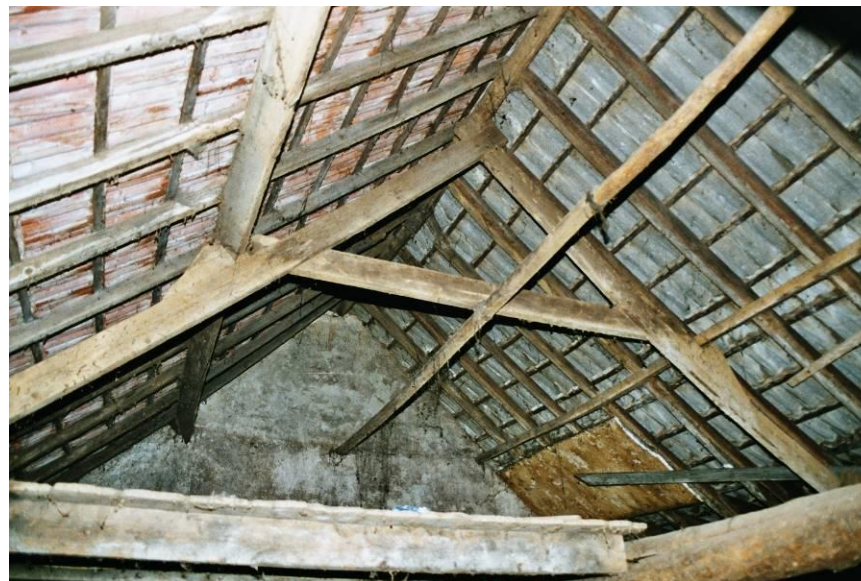
Deel van de oorspronkelijke dakconstructie van de varkensschuur. Bron: BBA.
