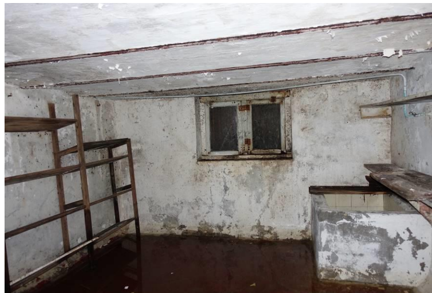
Overzicht kelder richting de linker zijgevel, met bovenliggende gepleisterde troggewelven tussen ijzeren liggers.
