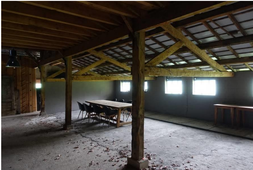
Zicht door de oostelijke beuk van het oorspronkelijke volume, met rechts de constructie van de uitbreiding.
