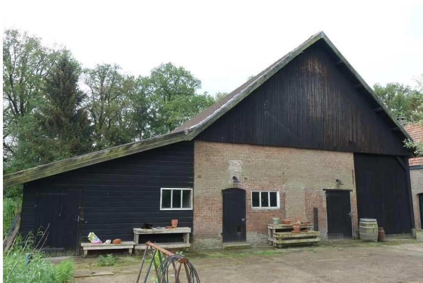
Overzicht achtergevel, met links van het oorspronkelijke gemetselde geveldeel de latere uitbreiding.
