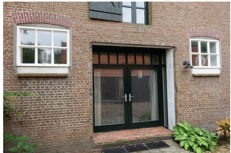
Achter de oorspronkelijke deeldeuropening werd een nieuwe pui ingevoegd.
