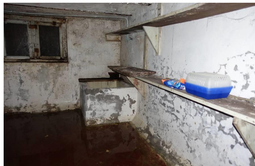
Zicht langs de achterwand van de kelder, met de betegelde bak.
