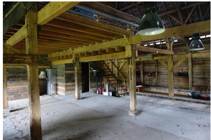
Overzicht van de constructie op de begane grond in zuidwestelijke richting.
