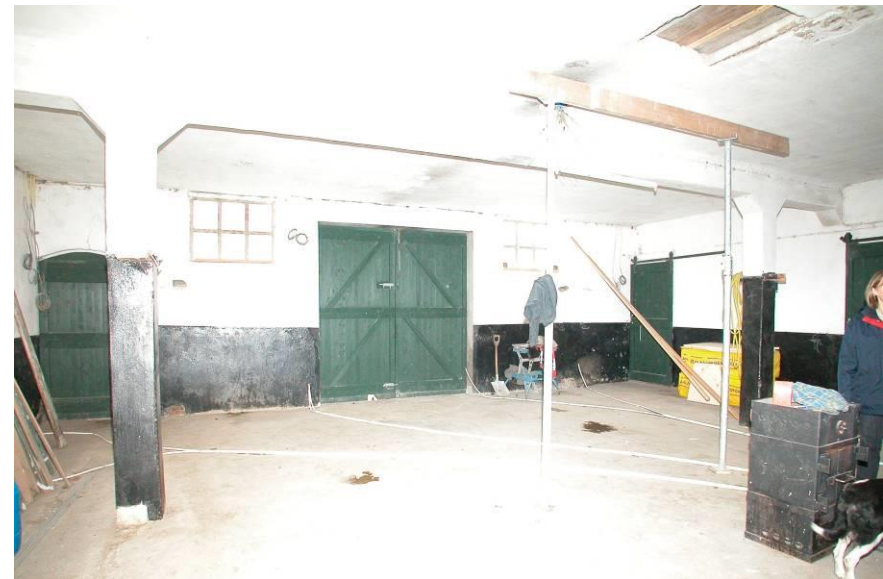
Zicht richting de achtergevel binnen het bedrijfsgedeelte in 2003. De betonvloer is dan recent aangebracht. Bron: BBA.
