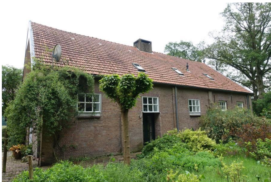
Overzicht van de linker zijgevel.
