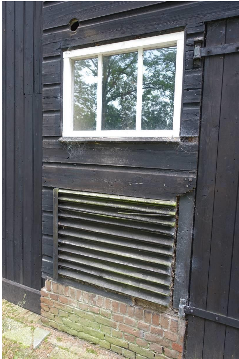
T.b.v. melkmachine ingevoegd houten lamellenrooster.
