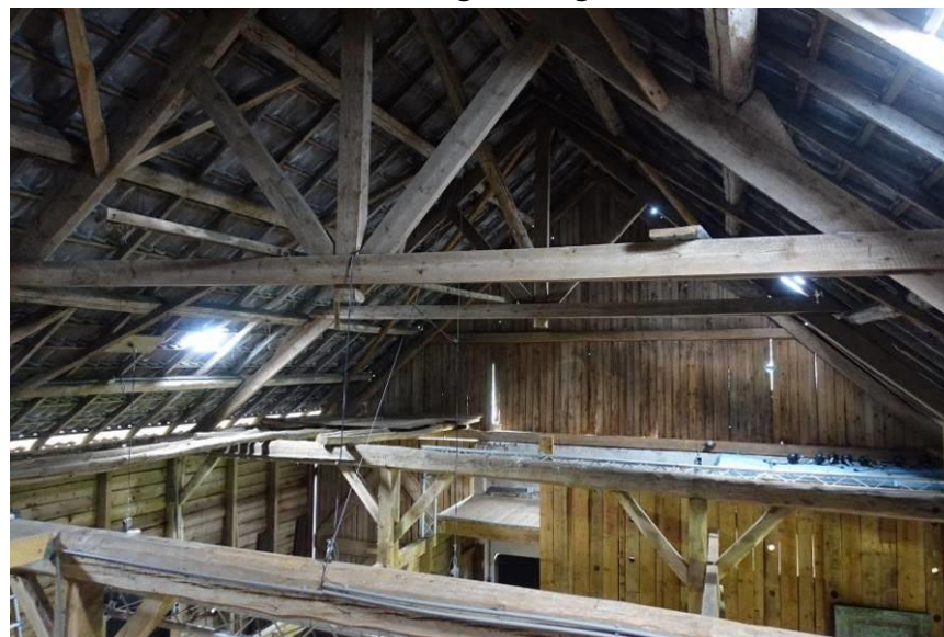
De dakconstructie gezien richting de achtergevel.
