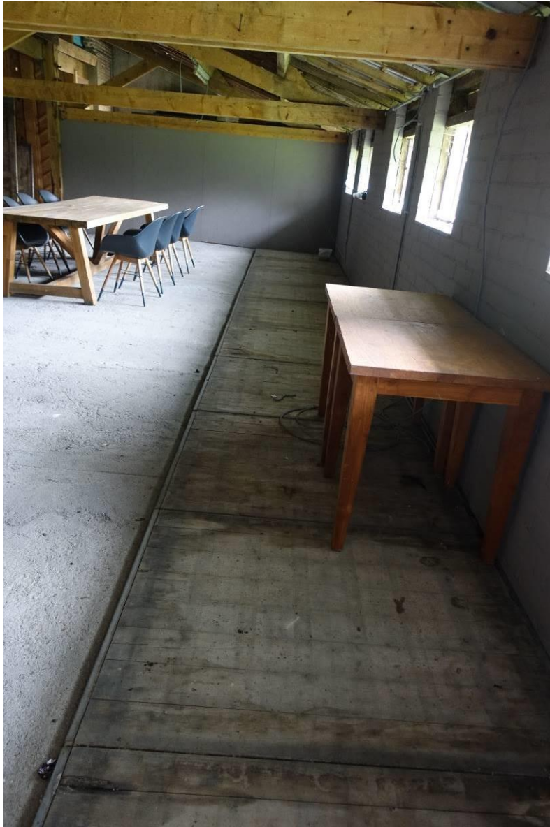
Ook binnen de uitbreiding werd langs de rechter zijgevel een grup aangelegd.
