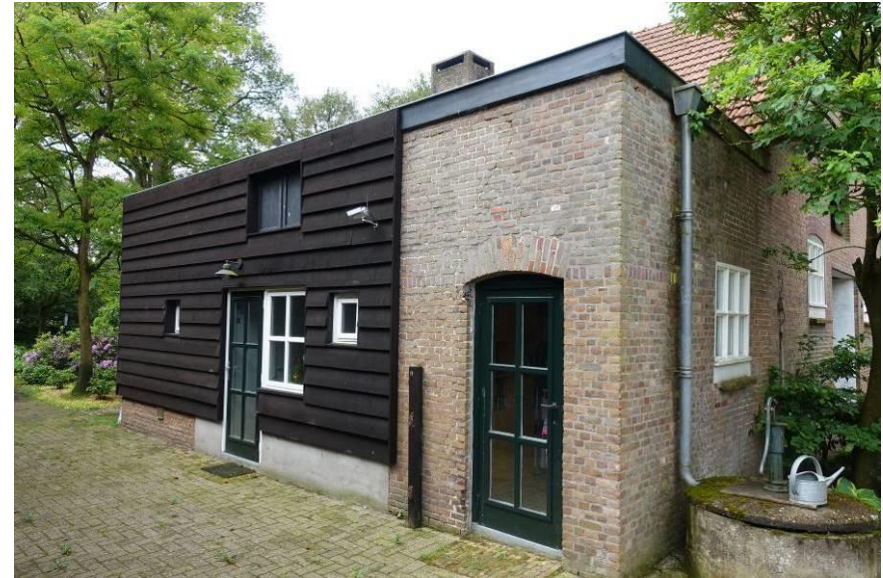
Overzicht van de uitbouw uit het noordoosten.
