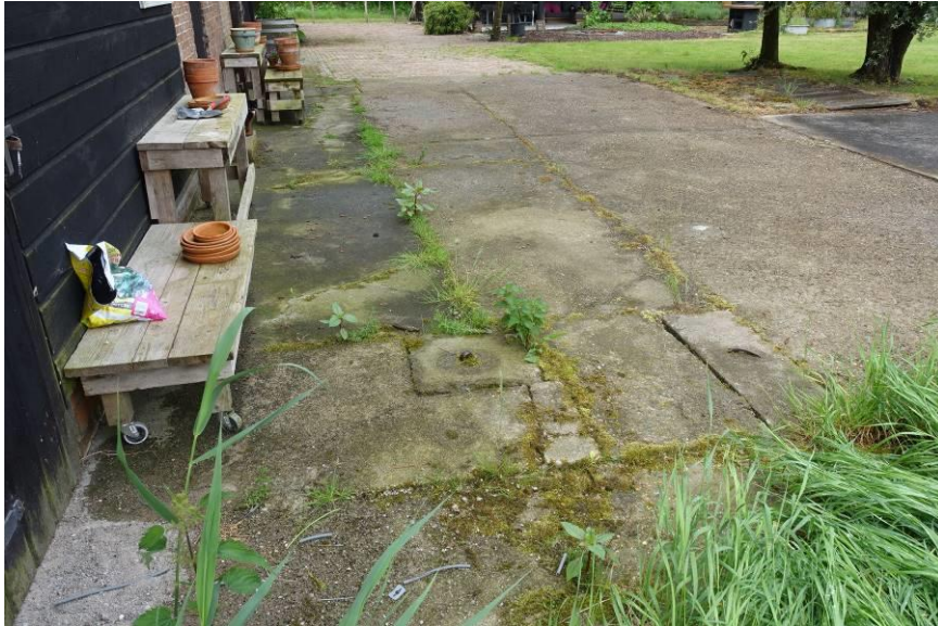
Achter de schuur is het terrein verhard met beton met daarin enkele putdeksels.
