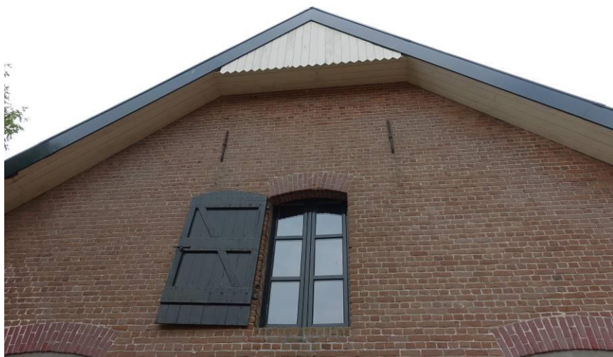
Bovenzijde van de achtergevel, met ook achter de zolderluikopening een later ingevoegd raam.
