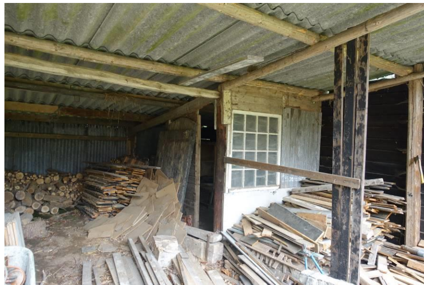
Noordoosthoek van de loods met een met hergebruikt materiaal afgescheiden ruimte.
