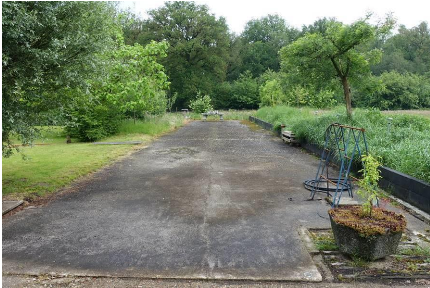
Betonnen kelderdek van de langs de oostrand van het erf aanwezige gierkelder (NM-Bouwwerknr. 11539).
