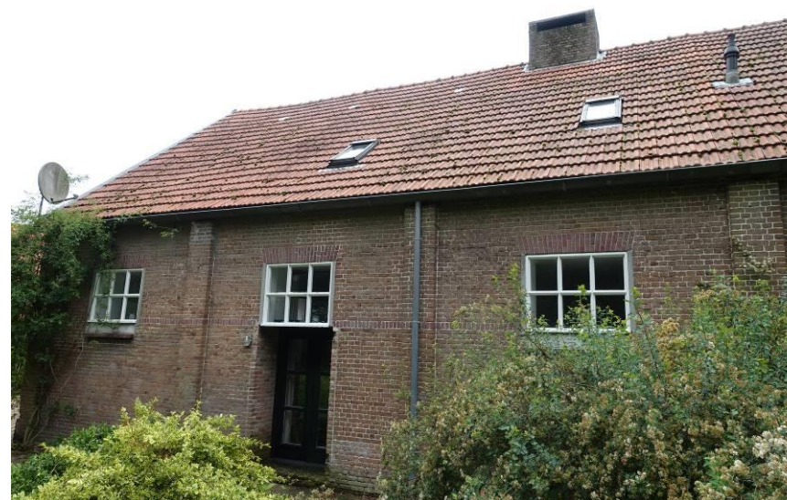
Bij het voormalige bedrijfsgedeelte is de plaats van de spanten afleesbaar aan de gemetselde lisenen.
