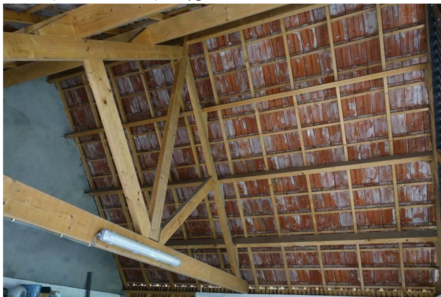
Het noordelijke dakvlak boven de werkplaats, met het boven deze ruimte aanwezige recente spant.
