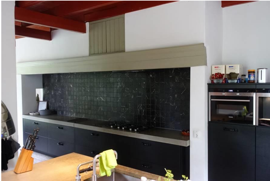
De keukenschouw werd sterk verbreed, zodat waarschijnlijk alleen de rechter zijwand nog oorspronkelijk is.
