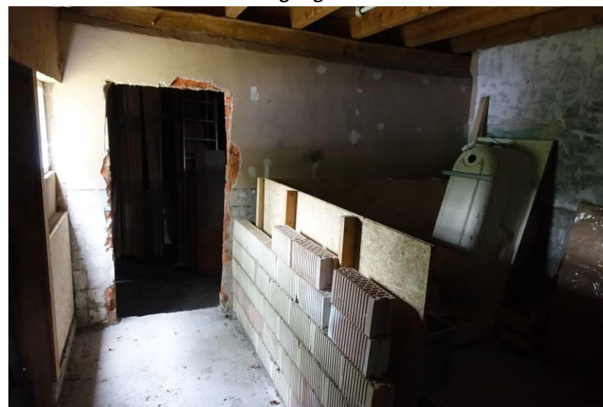
De recent toegevoegde wanden zijn opgetrokken van porisoblokken.
