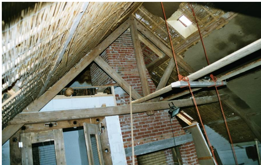
Zicht op de brandmuur vanaf de achterzolder in 2003. De stookplaats is dan recent gemetseld. Bron: BBA.
