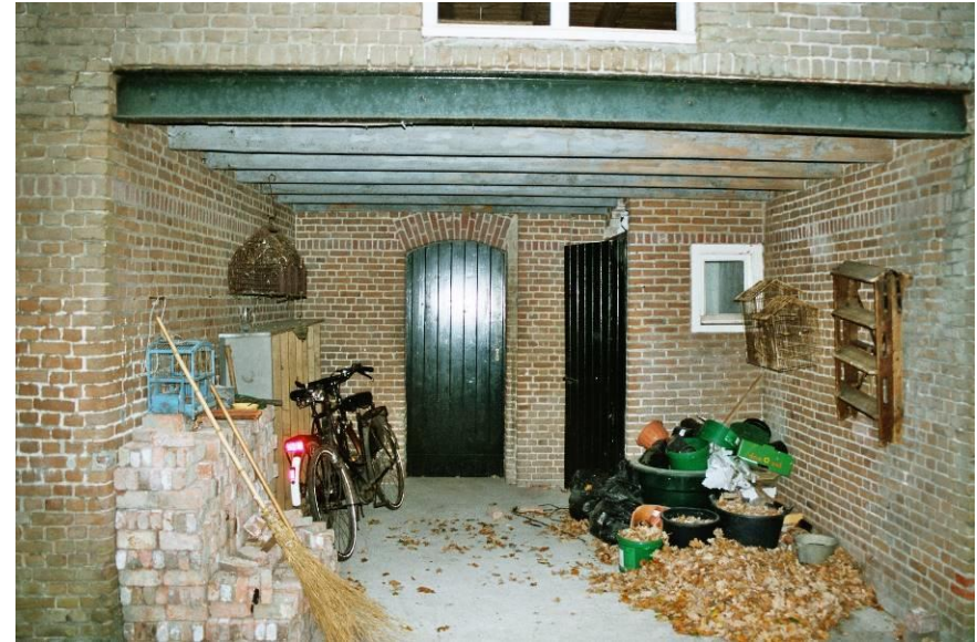
Beeld van de overdekte plaats binnen de uitbouw in 2003. Bron: BBA
