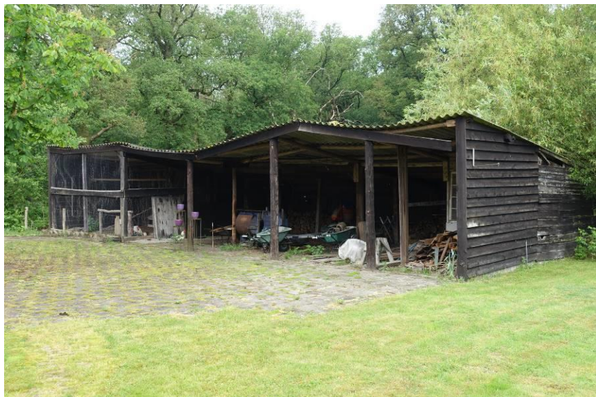
Overzicht van de loods uit het zuidoosten.
