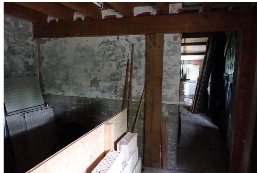
Een deel van de wanden van de in aanbouw zijnde Bed&Breakfast in de voorste travee behoort tot een eerder aangelegde melkmachineruimte.
