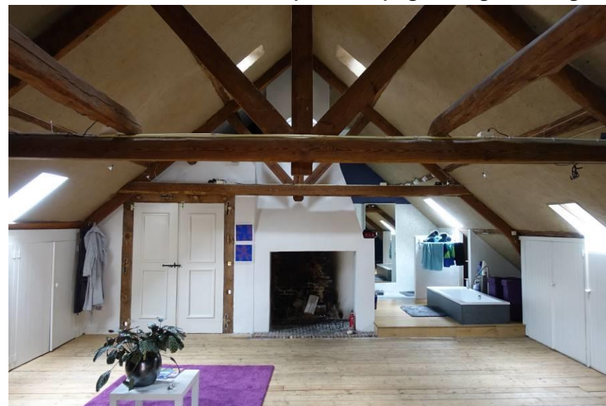
Overzicht van de achterste ruimte richting de brandmuur met ook hier een forse ingevoegde schouw.
