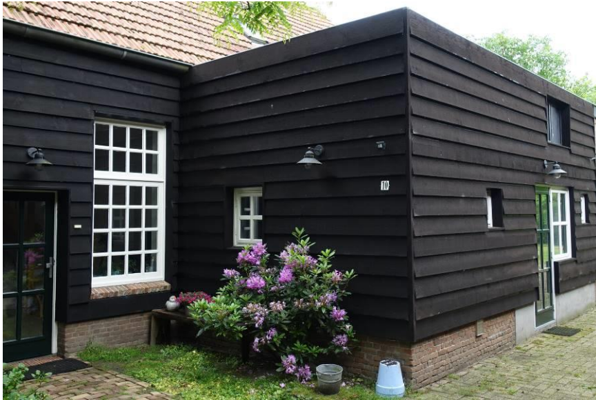
Overzicht van de voorgevel van de uitbouw. Het in deze gevel aanwezige kozijn werd links binnen een groter venster geplaatst.
