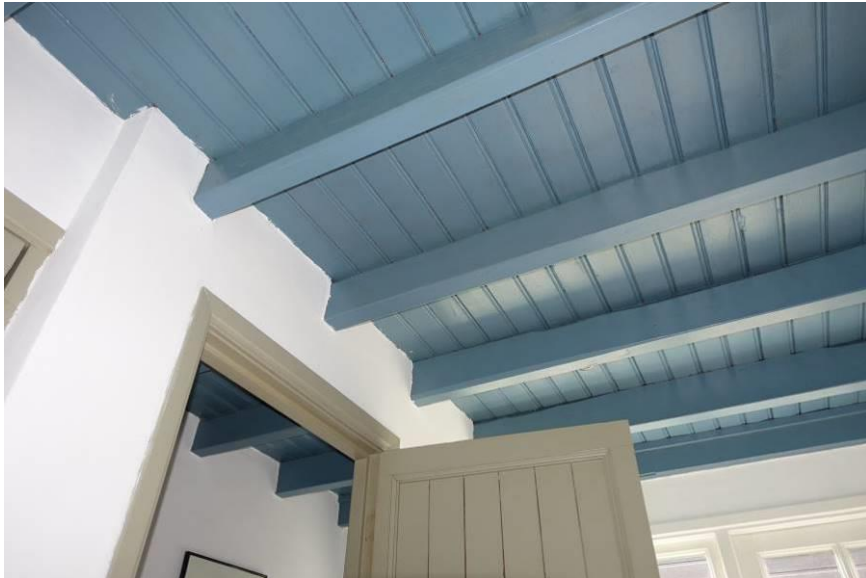
Later ingevoegde enkelvoudige balklaag binnen het middelste deel van de uitbouw.
