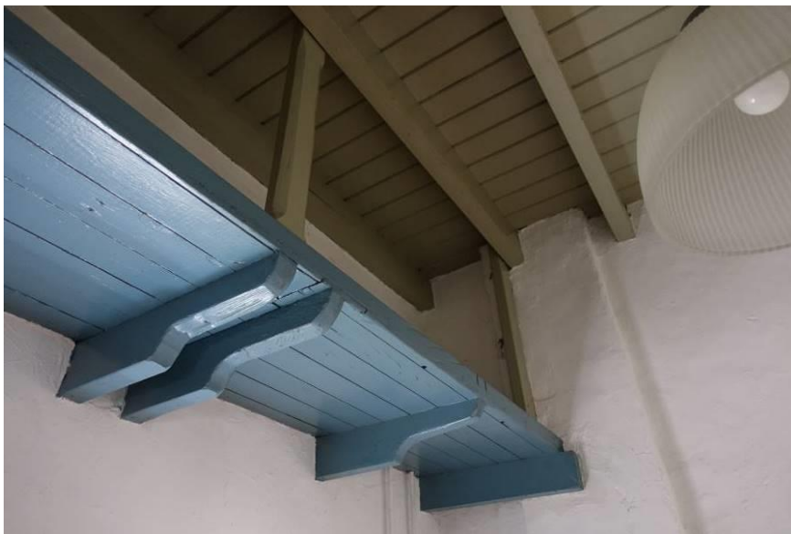
Enkelvoudige dakbalklaag van de uitbouw, naast de voorgevel.
