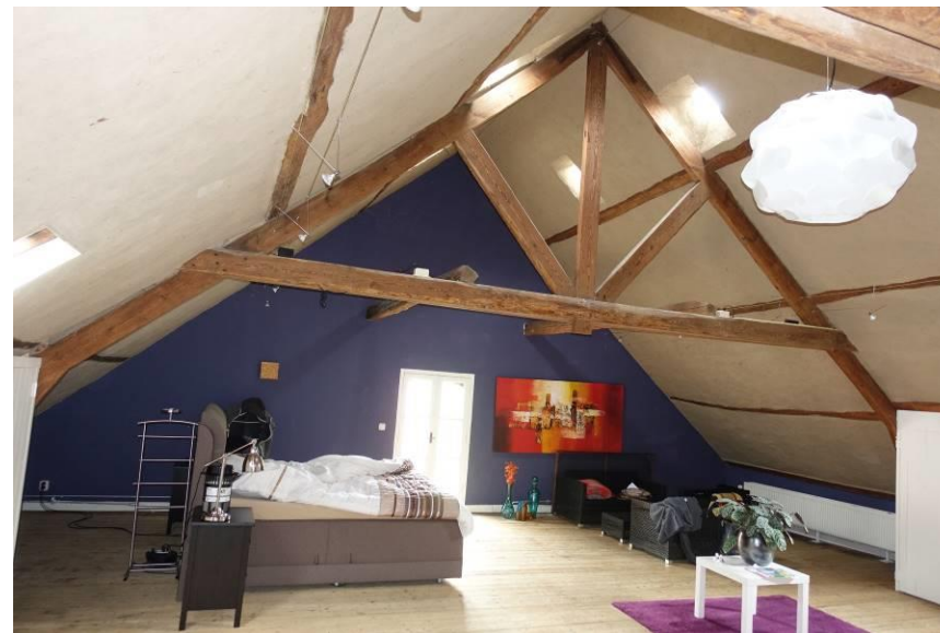
Achterste van de twee oorspronkelijke Hollandse spanten boven het vroegere bedrijfsgedeelte.
