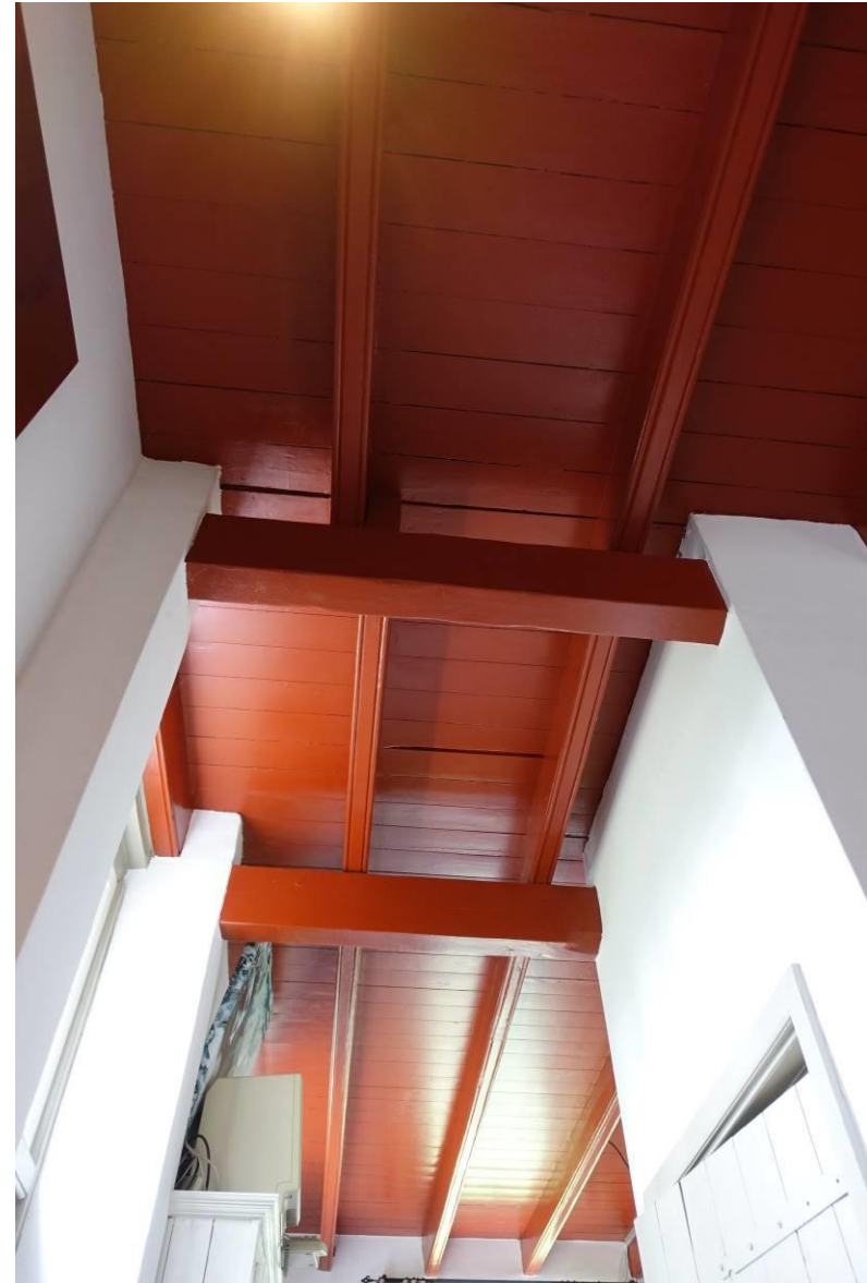
Bij de voordeur is de oorspronkelijke gangstructuur alleen nog herkenbaar aan de twee onderslagen ter plaatse van de vroegere wanden.
