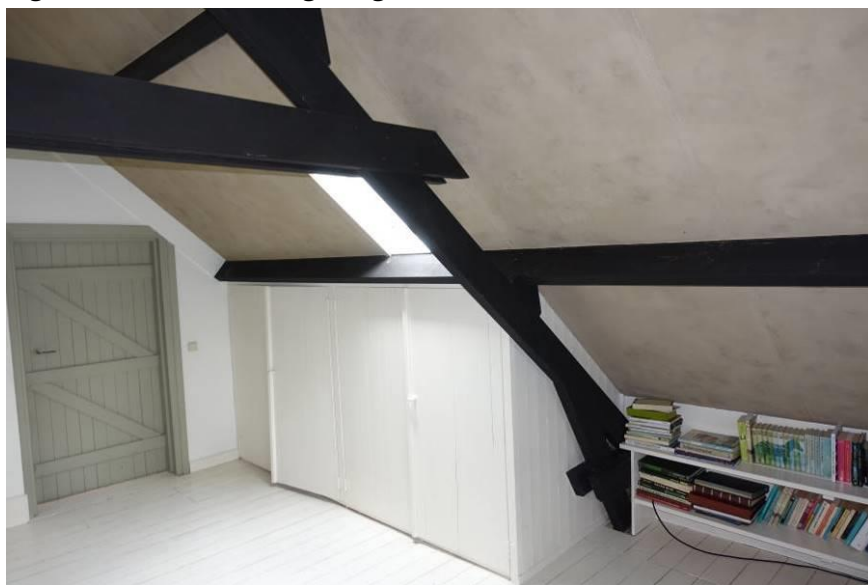
Rechter dakvlak met links de nieuwe toegangsdeur door de brandmuur.
