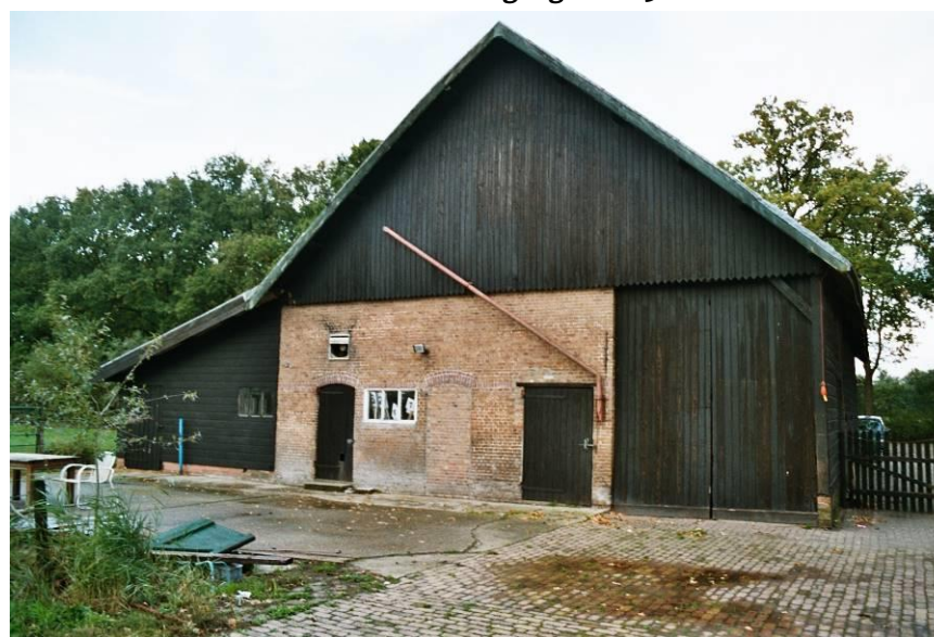
Overzicht van de achtergevel van de schuur in 2003. Bron: BBA.
