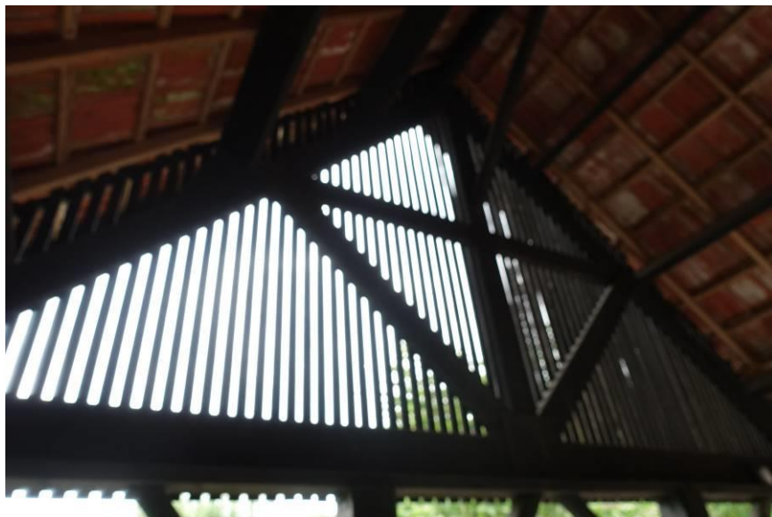
Binnenzijde van de oostelijke topgevel.
