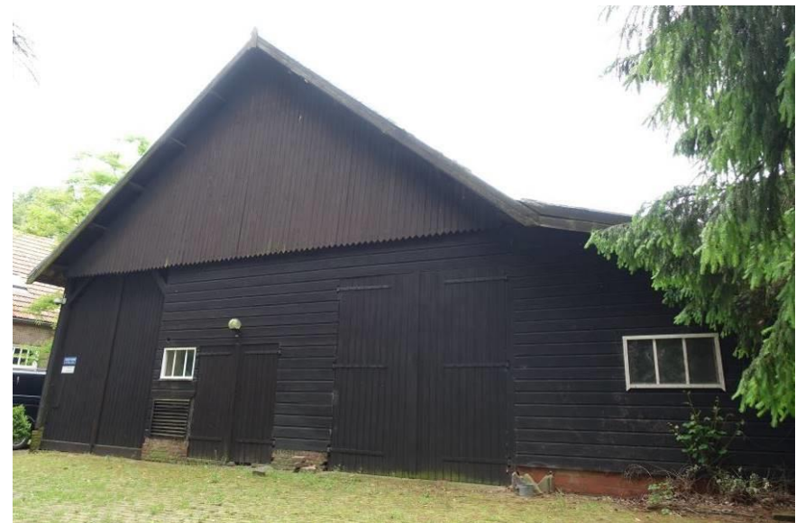
Overzicht van de voorgevel van de schuur.
