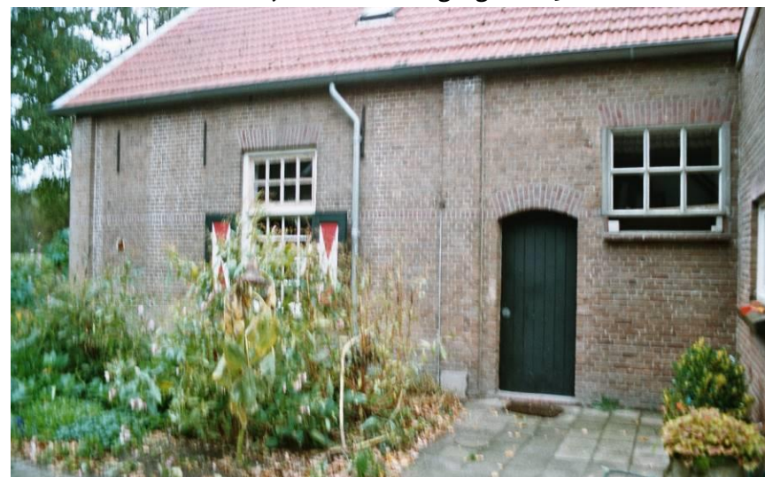
De rechter zijgevel van de boerderij in 2003, met rechts nog de oorspronkelijke deur en een betonnen stalraam. Bron: BBA
