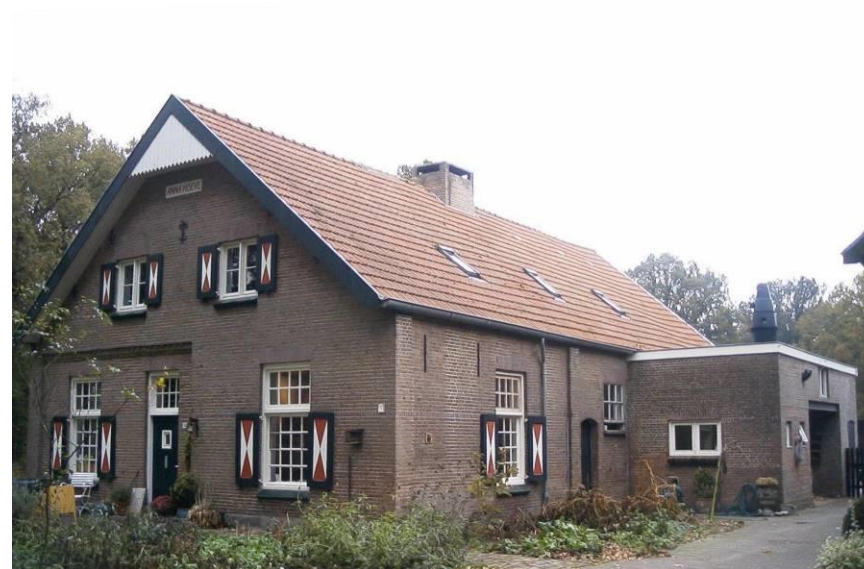
Overzicht van de boerderij vanaf de erftoegang in 2003. Bron: BBA
