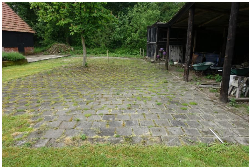
Het met betongtegels bestrate terrein tussen de loods en de varkensschuur.
