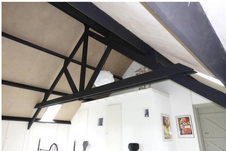
Het vernieuwde Hollandse spant boven het voormalige woongedeelte.
