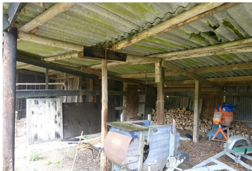
Overzicht van het interieur en de constructie in noordwestelijke richting.
