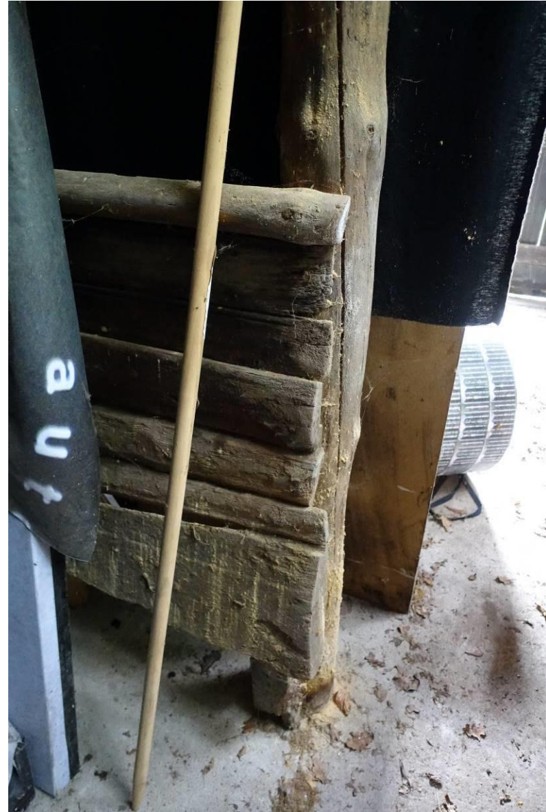
Restant oude houten wand met rondhouten stijl, gezien richting zuidgevel.
