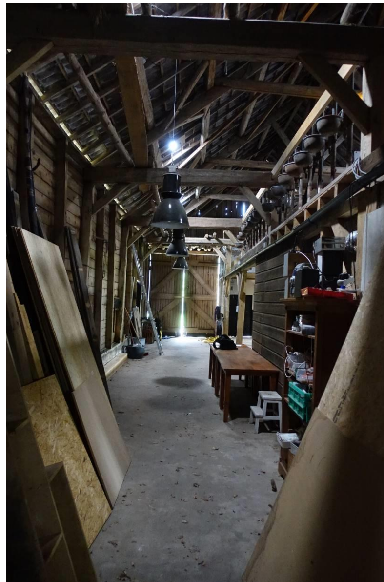
Zicht door de langsdeel.
