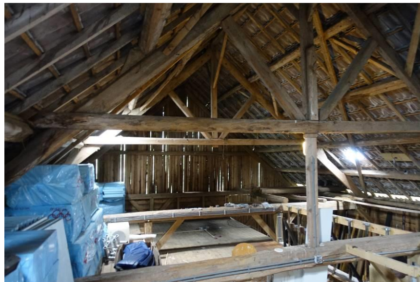
Zicht door de dakconstructie richting de voorgevel.
