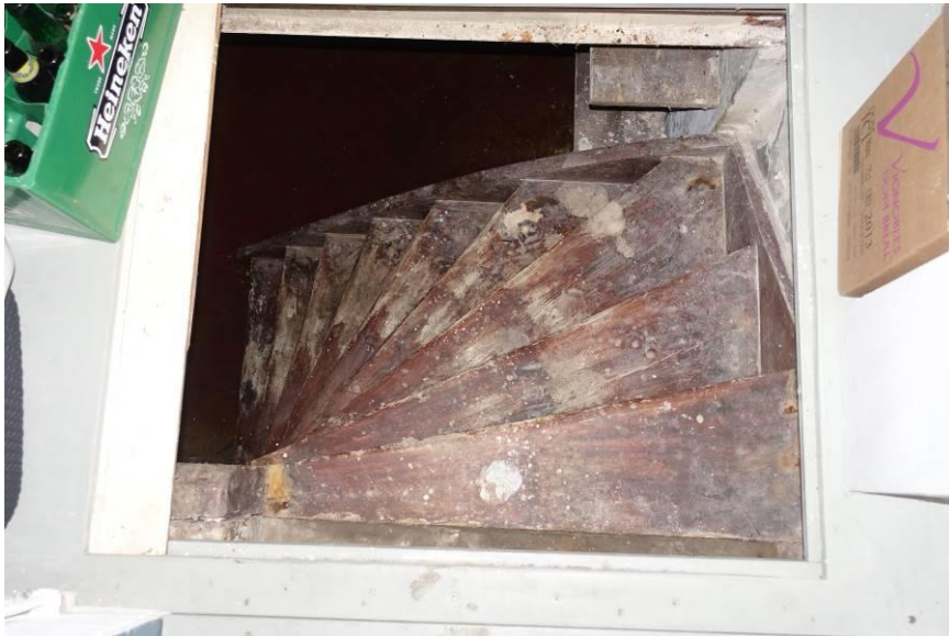
Zicht op de oorspronkelijke keldertrap vanaf de begane grond.
