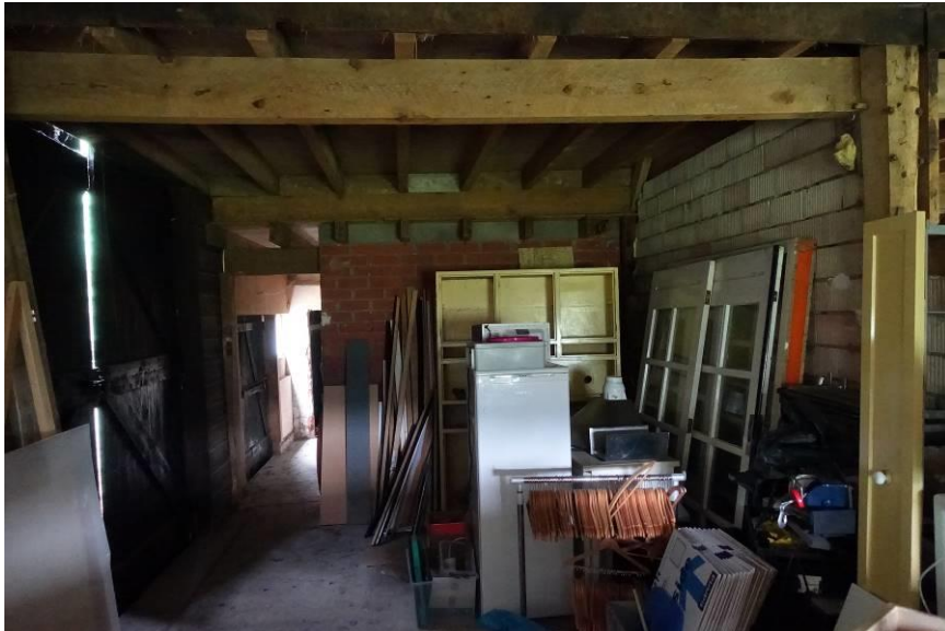
Later ingevoegde balklagen boven de ruimtes in de voorste (zuid) travee.
