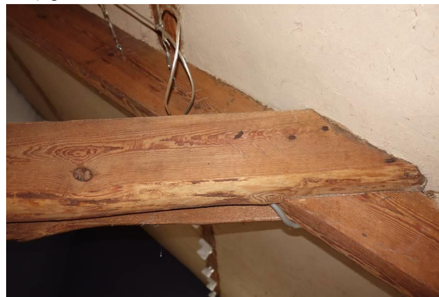
Detail van de rechte gehakte telmerken (hier merk IIII).
