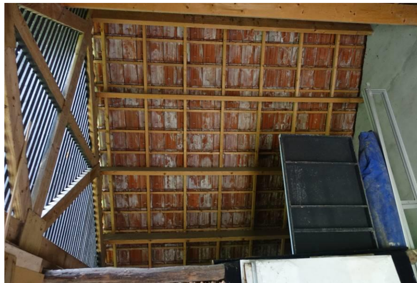
Noordelijk dakvlak van de westelijke ruimte.
