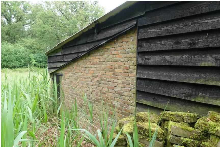
In de westgevel tekent zich het in 1952 uitgebreide kippenhok nog af.
