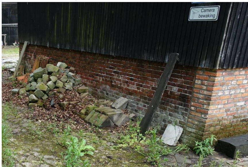
Detail van de grotendeels oudere voetmuur van de westgevel. Rechts het met hergebruikte steen vernieuwde metselwerk van de zuidgevel.
