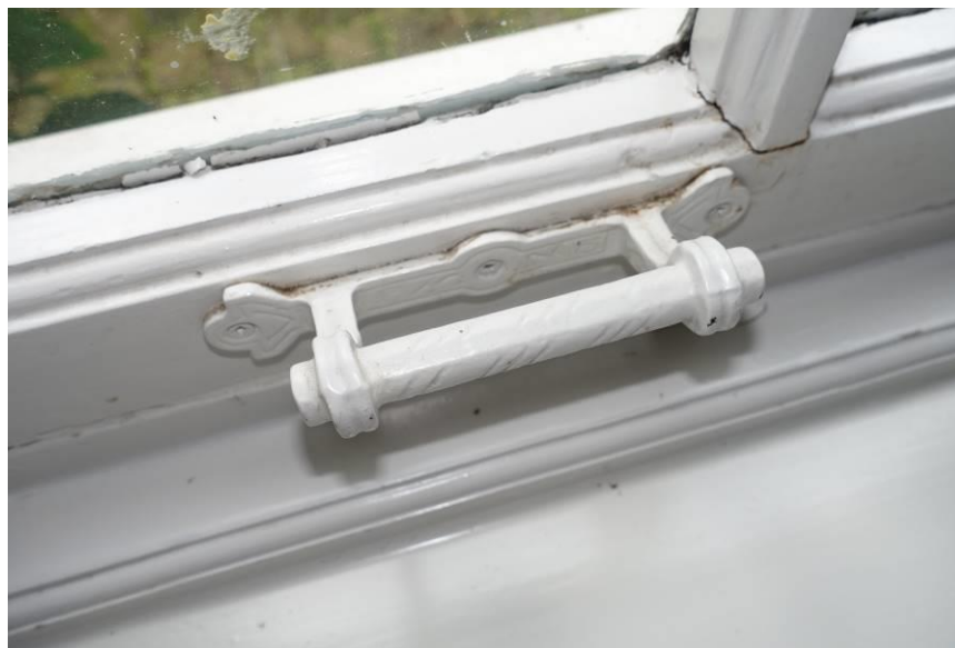
Detail van één van de oorspronkelijke handgrepen op de schuiframen.
