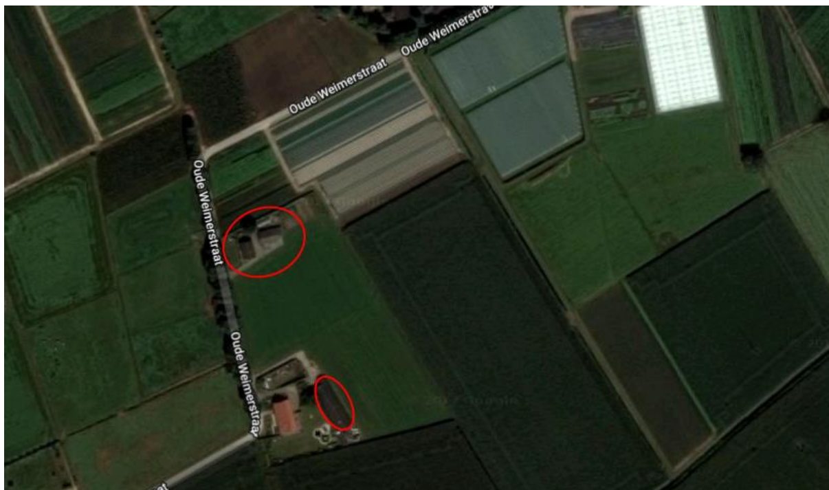
Luchtfoto Oude Weimerstraat 5 en bijbehorende schuur achter Oude Weimerstraat 7 (bron: Google Earth)
