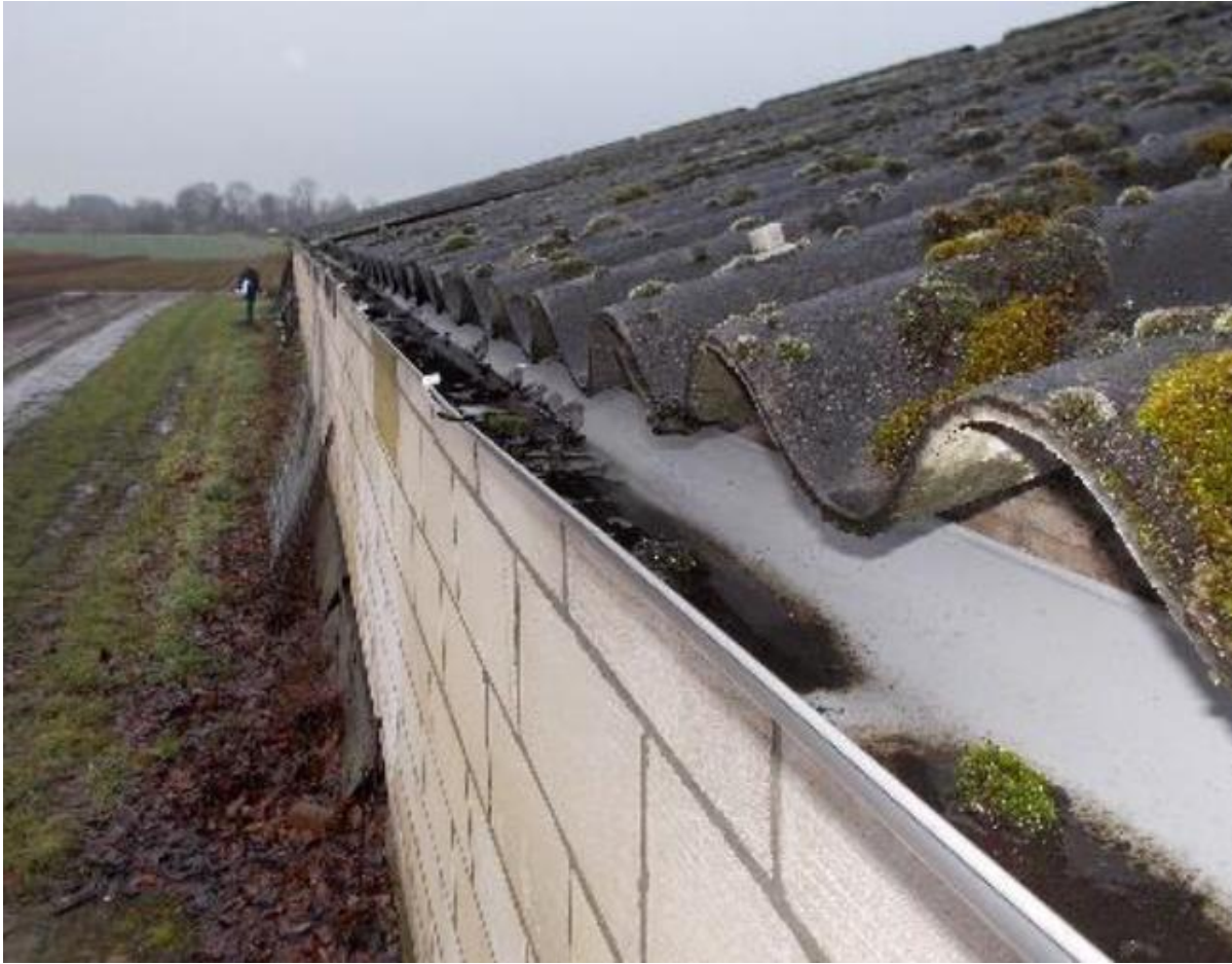
Dakbedekking en goot te slopen schuur.
