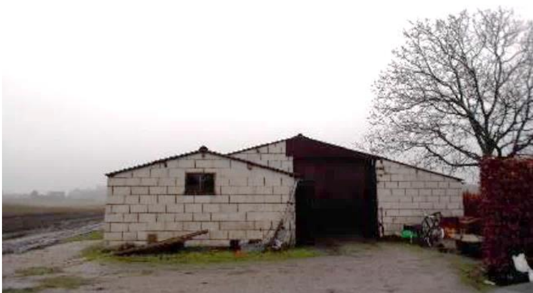
Voorgevel te slopen schuur
