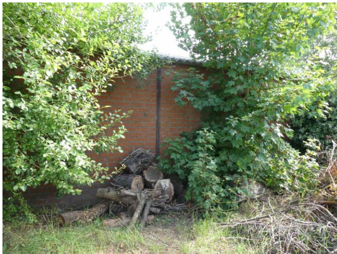
Figuur 7: Buitenkant loods B.
