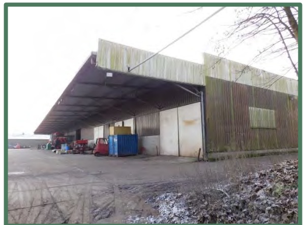
Achterzijde werkplaats met overkapping
