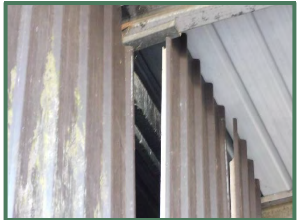
Openingen in afgesloten deel loods
