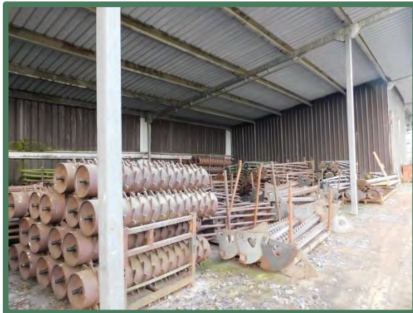
Loods met op de achtergrond het afgesloten gedeelte
