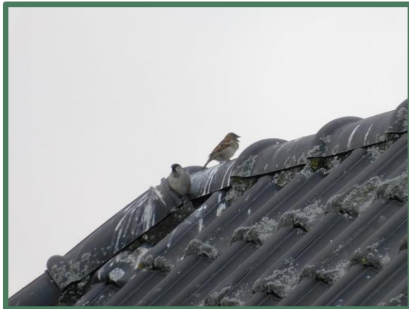
Huismussenkoppel op de nok van 5c
