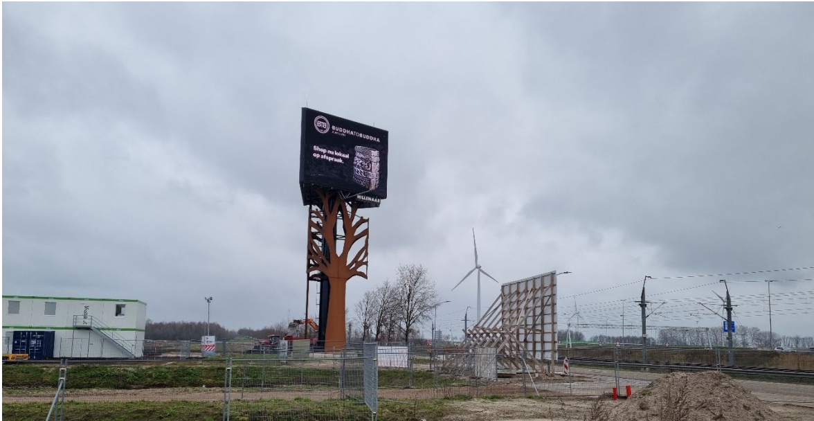
Foto reclamemast bij entree bedrijventerrein
