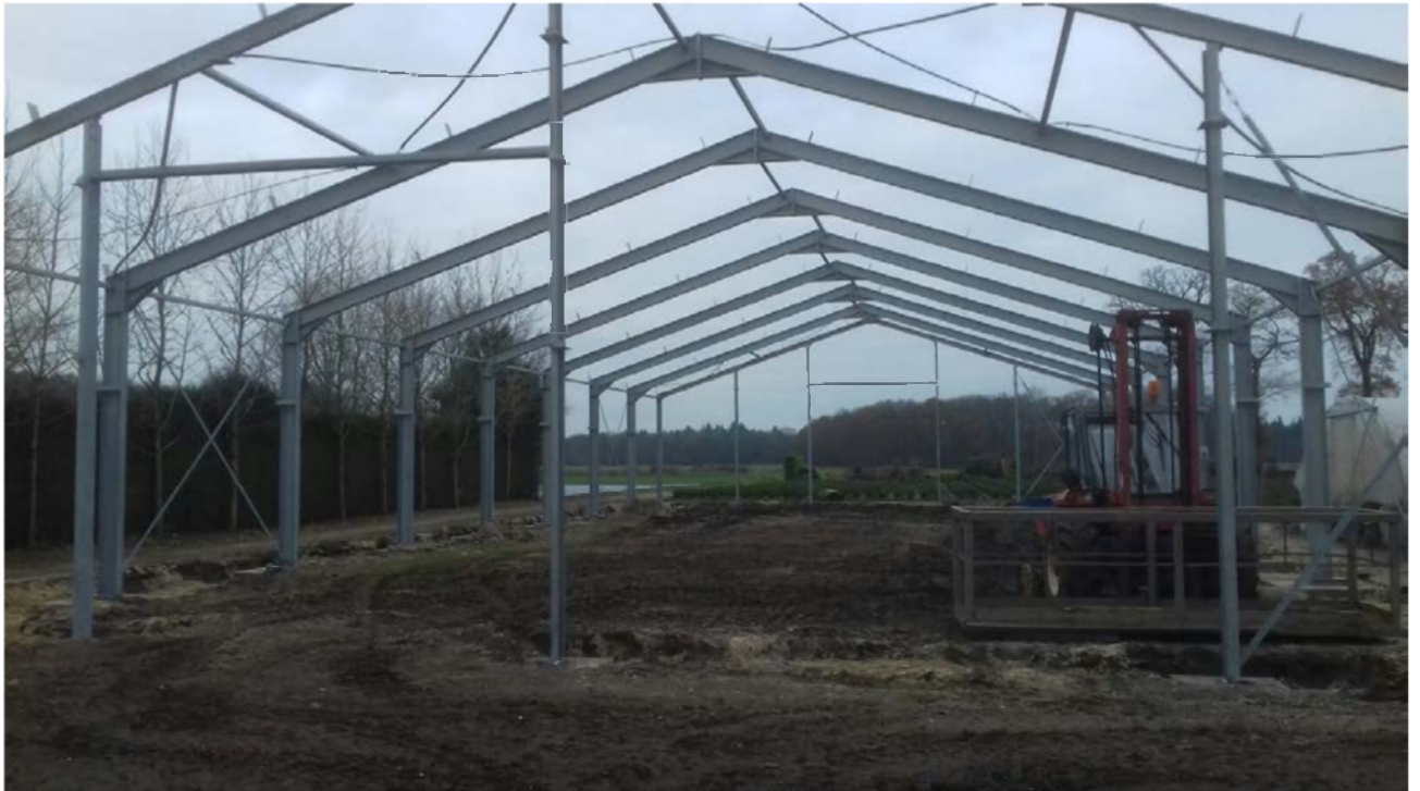
Afbeelding 13: foto van in aanbouw zijnde loods: hier is geen bomenteelt meer mogelijk
