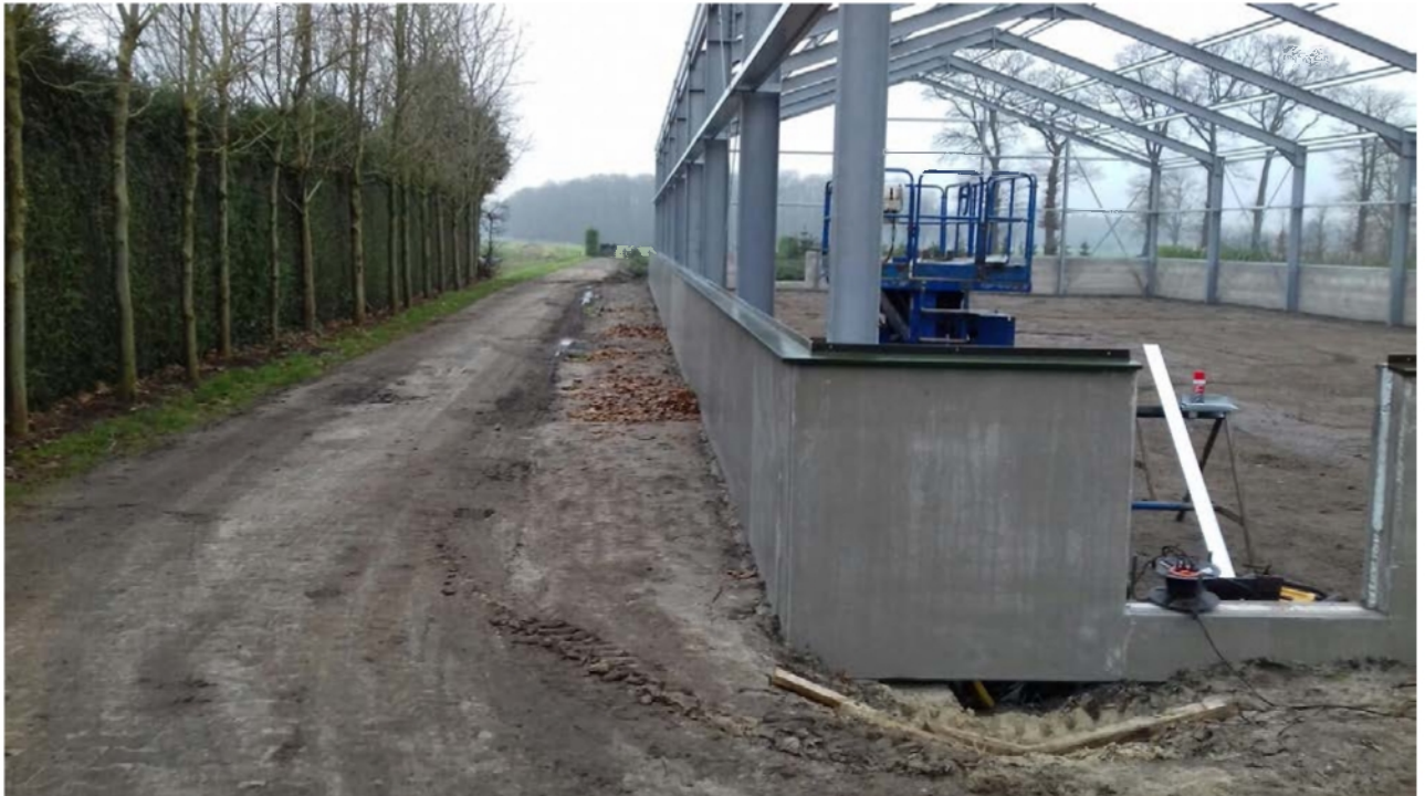
Afbeelding 20 : foto van verhard pad met daarnaast vrije ruimte en in aanbouw zijnde loods
