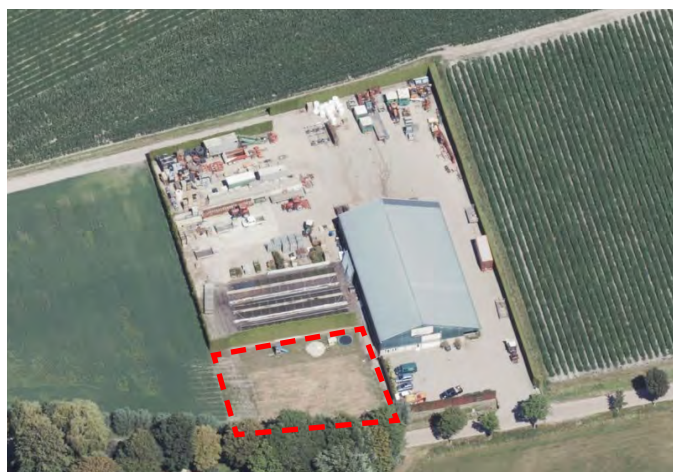
Luchtfoto bedrijfslocatie (bouw bedrijfswoning binnen rode contour)
