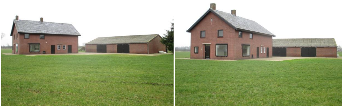
Figuur 5: foto's van bestaande situatie Lepelstraat 11
