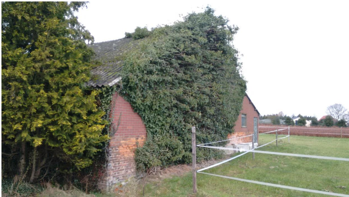
Zuidelijke muur te slopen oude schuur
