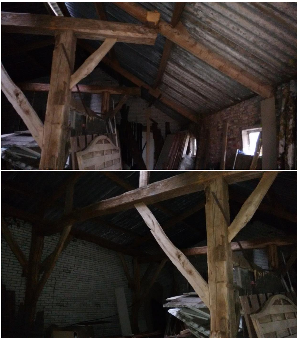
In de te slopen oude schuur
