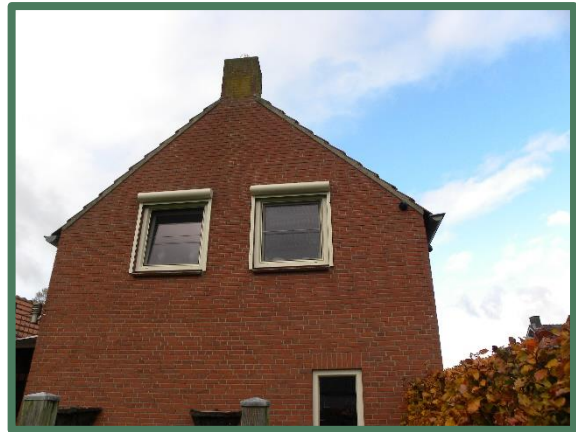
Foto 10: oostelijke wand woning.
