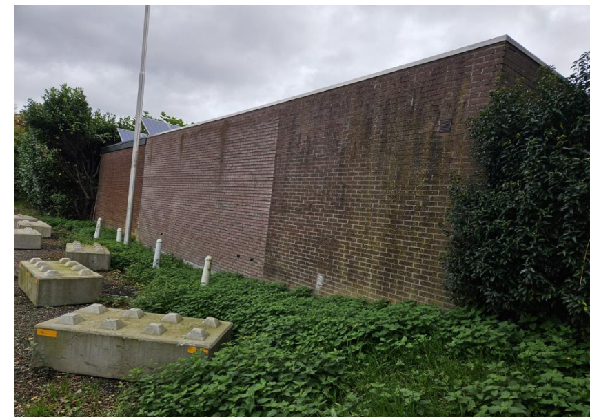
Figuur 18: Plangebied 3 naastgelegen gebouw aan de oostzijde
