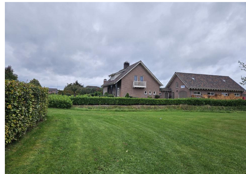
Figuur 21: Plangebied 4 naastgelegen huizen westzijde
