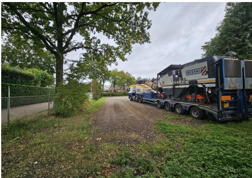
Figuur 16: Plangebied 3 gezien vanuit het zuiden
