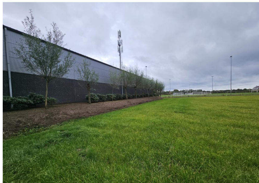
Figuur 5: Plangebied 1 aanzicht loods aan de zuidoostzijde
