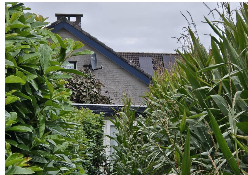
Figuur 12: Plangebied 2 aanzicht op achterzijde Julianalaan 23
