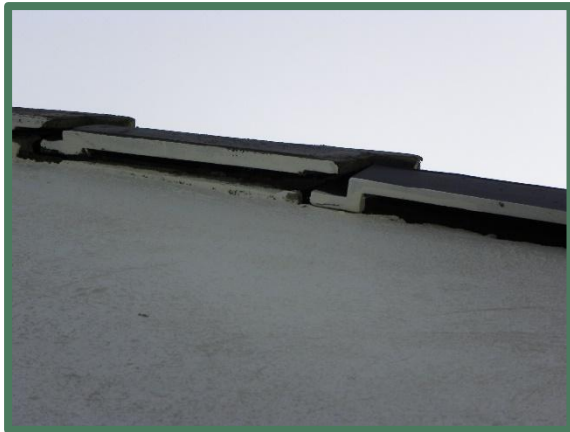
Kantpannen aan westelijke kopgevel woning
