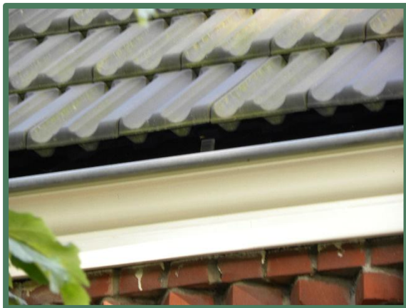
Pannendak woning vanaf het zuiden
