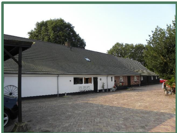
Stuivezandseweg 41 vanuit het noordoosten
