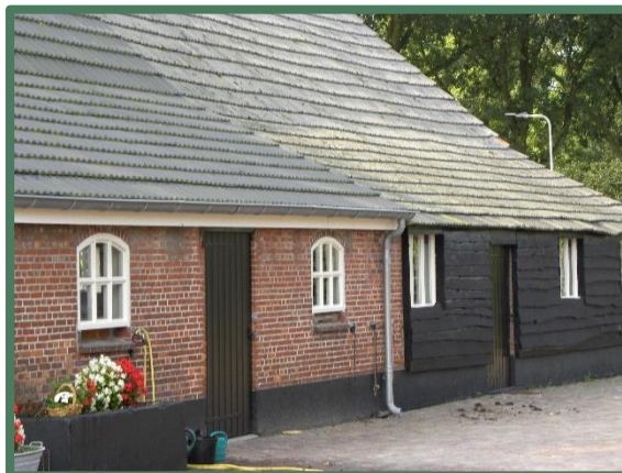
Stuivezandseweg 41 vanuit het noordoosten
