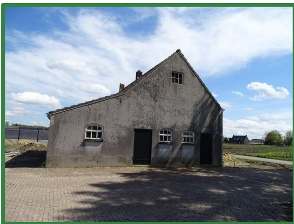
Figuur 9: Woonhuis vanaf het westen dak
