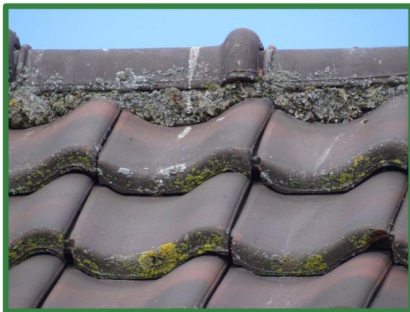
Figuur 22: Nokpannen aangesmeerd met cement
