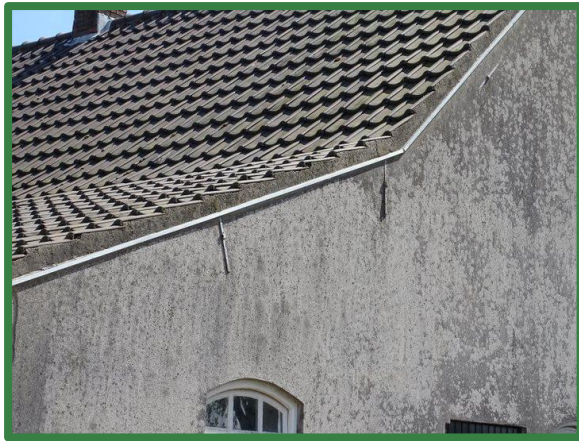
Figuur 18: Aangesmeerde kantpannen, westelijke zijgevel
