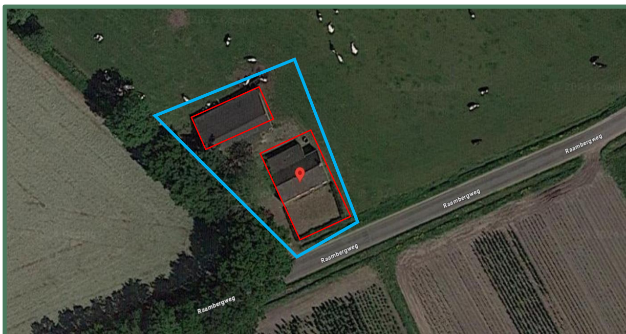
Figuur 3: Globaal omlijnd plangebied in blauw, te slopen bebouwing in rood omkaderd. Bron: Google Earth.
