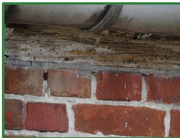
Figuur 25: Gesloten met een muurplaat
