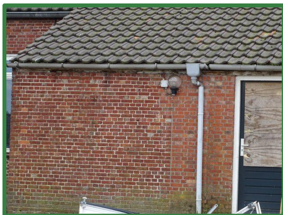
Figuur 24: Ruimte tussen muur en goot gesloten (aanbouw)
