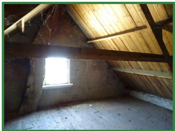
Figuur 10: Binnenzijde woonhuis, vanaf de zolder met zicht op het dak
