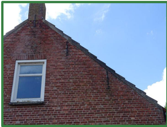
Figuur 20: Aangesmeerde kantpannen, oostelijke zijgevel
