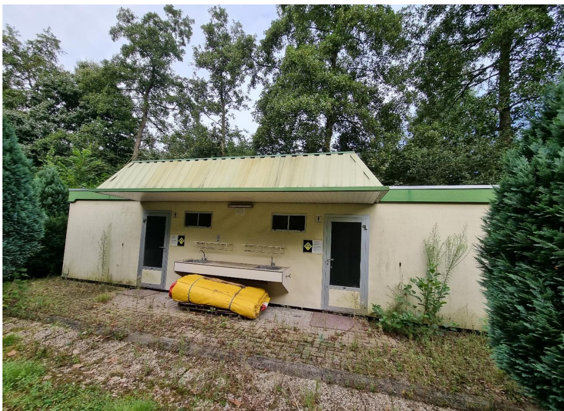
Figuur 9 Eén van de aanwezige toiletgebouwen op het campingterrein.
