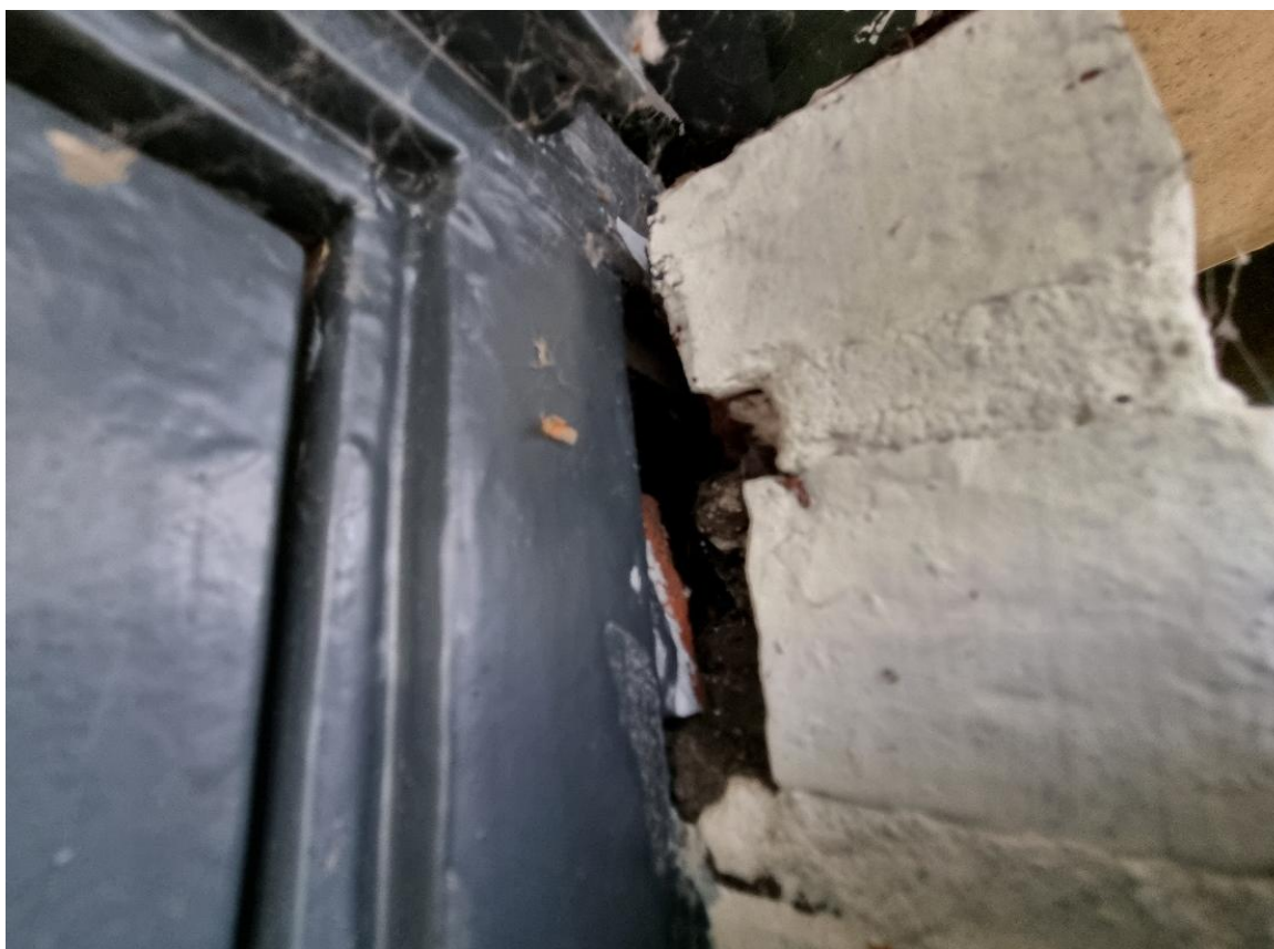
Figuur 20 Het horecagebouw bevat een aantal ruimtes die eventueel geschikt zouden kunnen zijn als verblijfplaats voor vleermuizen.
