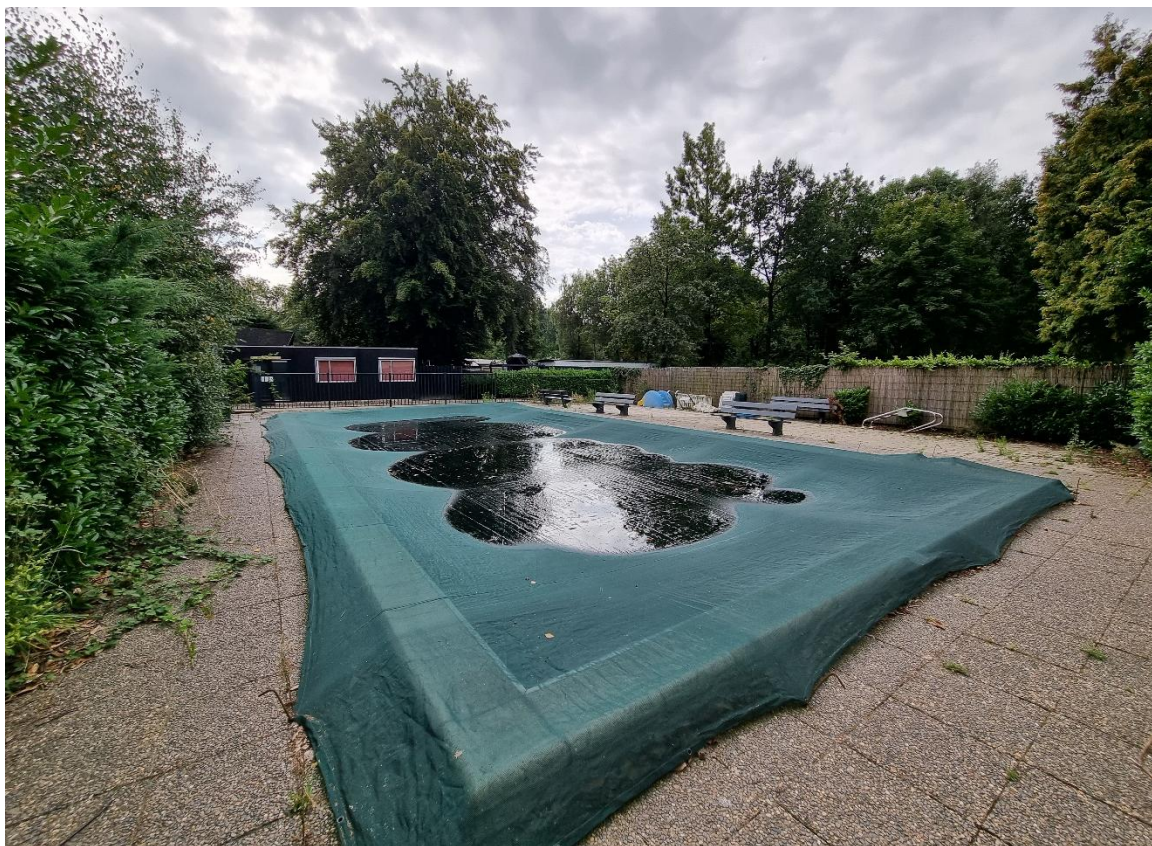
Figuur 11 Het buiten gebruik zijnde zwembad.
