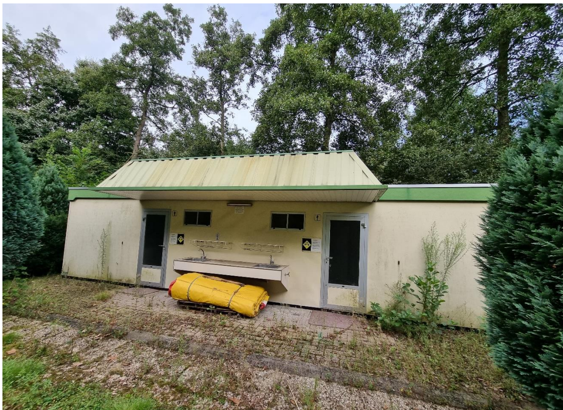
Figuur 3 Eén van de aanwezige toiletgebouwen op het campingterrein.
