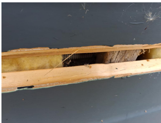
Houtenbeplating onder kozijnen bij de receptie daar zijn geen asbestverdachte materialen achter aangetroffen.
