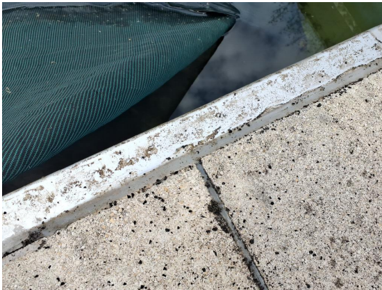
Afdichtingskitten bij zwembad niet asbestverdacht net zo als het zwembad zelf daar ligt zeil in.
