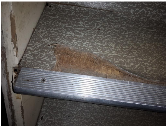
Zeil op trap van de kelder niet asbestverdacht
