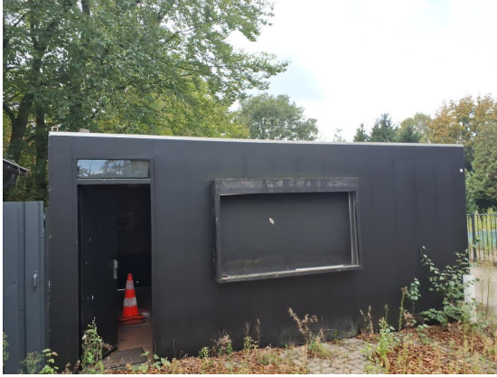
Container units naast receptie niet asbestverdacht deze zijn te nieuw.
