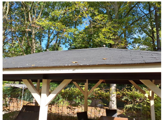
Daksingels overkapping niet asbestverdacht
