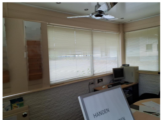
Boven plafonds geen asbestverdachte materialen aangetroffen bij de receptie
