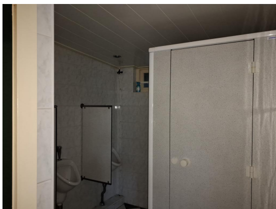
Toiletten wand en vloertegels niet asbestverdacht.
