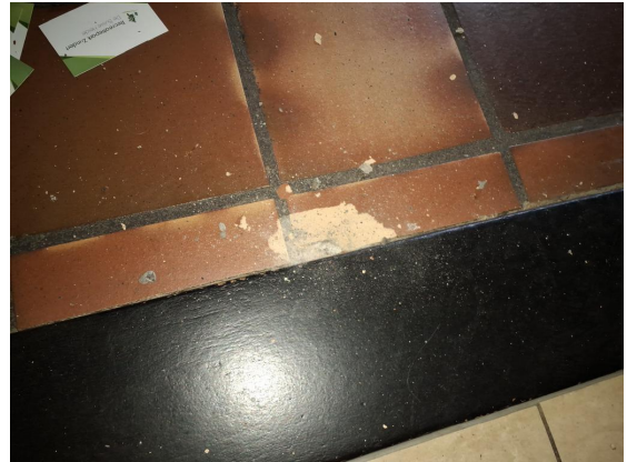
Vloertegels kantoor in de specie
