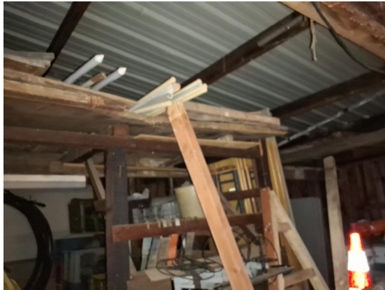
Damwand platen als dak
