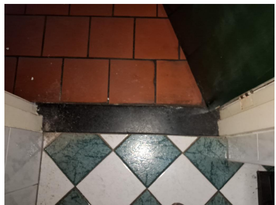
Dorpels niet asbestverdacht
