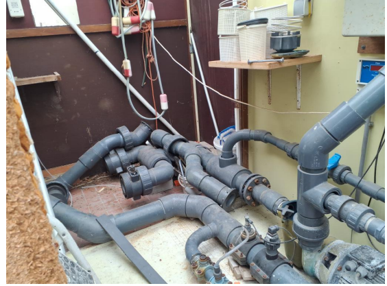
Technische ruimte zwembad daar zijn geen asbestverdachte materialen aangetroffen.
