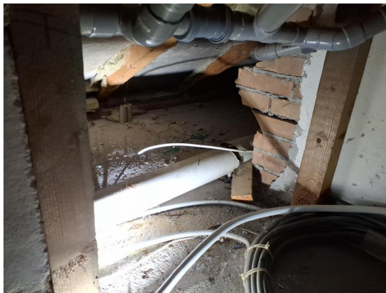
Leidingisolatie niet asbestverdacht
