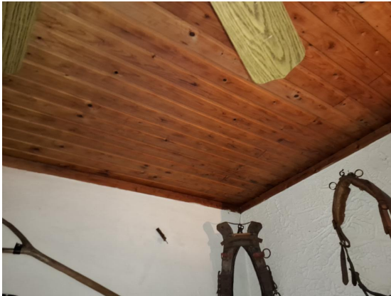
Boven plafonds geen asbestverdachte materialen aangetroffen
