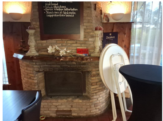
Openhaard/schouw niet asbestverdacht
