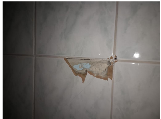
Wandtegels+lijm niet asbestverdacht 1 laag tegels
