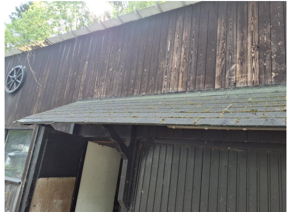
Houten beplating van de schuur
