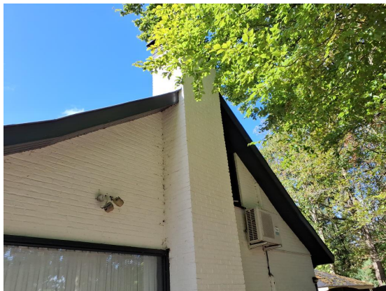
Schoorsteen kanaal niet asbestverdacht
