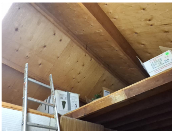
Houten dakbeschot bij receptie
