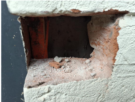
Vensterbanken in de woning zijn niet asbestverdacht
