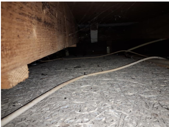
Boven plafond bij de bar met cementvezel platen
