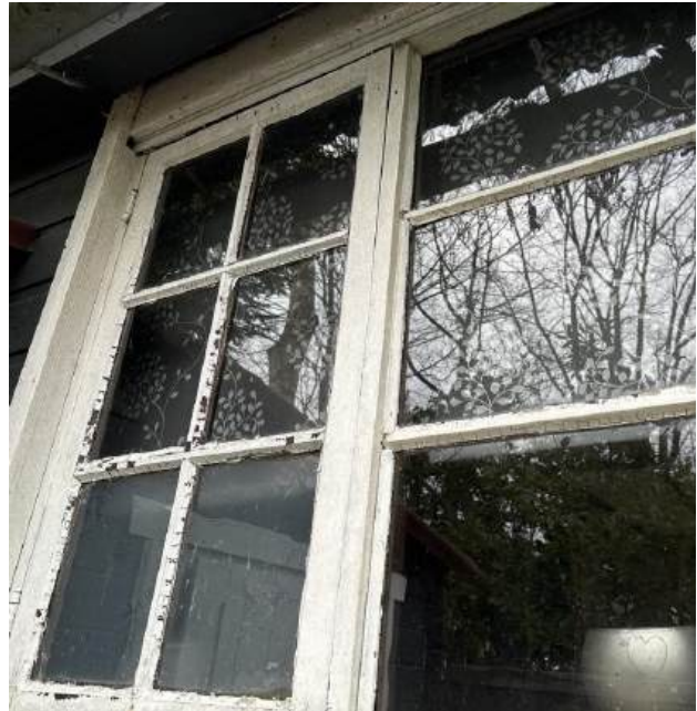
Foto 56 kit/ stopverf asbestvrij zie M03 en M04
