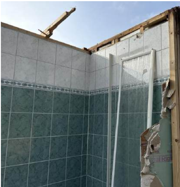
Foto 9 restanten terrein A, tegellijm niet verdacht
