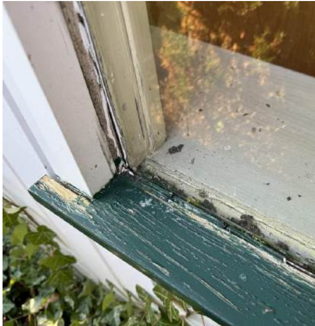
Foto 216 kit asbestvrij zie M10 en M11
