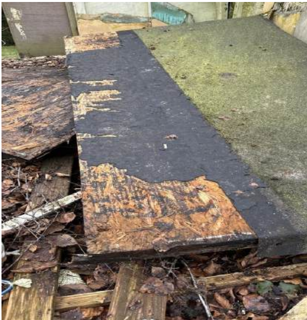
Foto 107 bitumen asbestvrij zie M05
