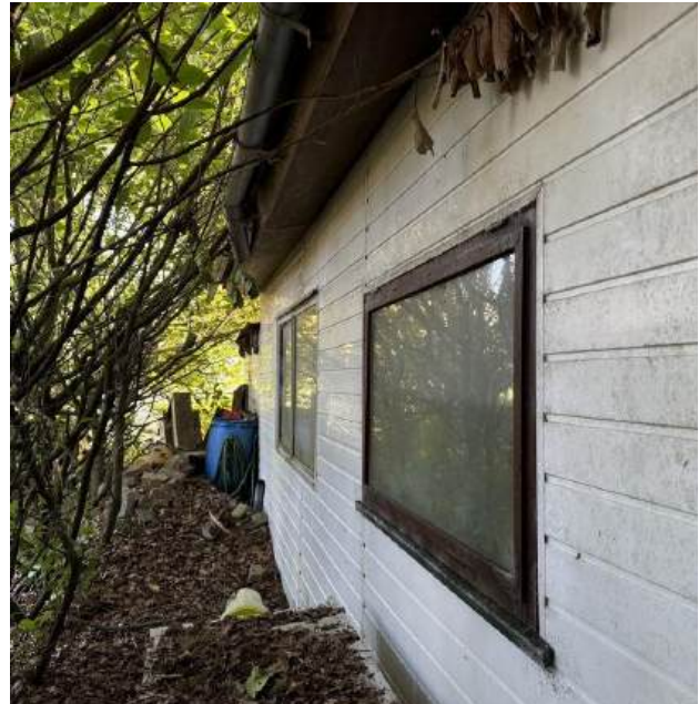
Foto 235 achterzijde stacaravan 181 met bron 2
