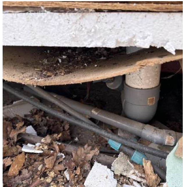
Foto 10 restanten terrein A, riolering PVC
