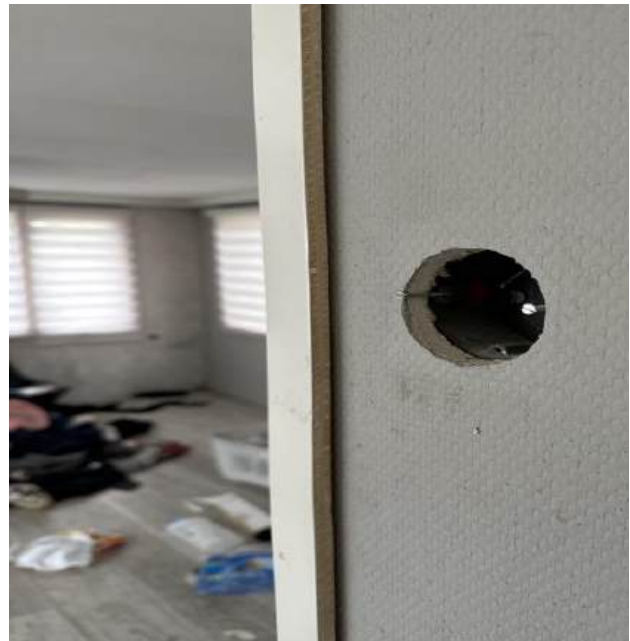
Foto 82 wanden van gipsplaat
