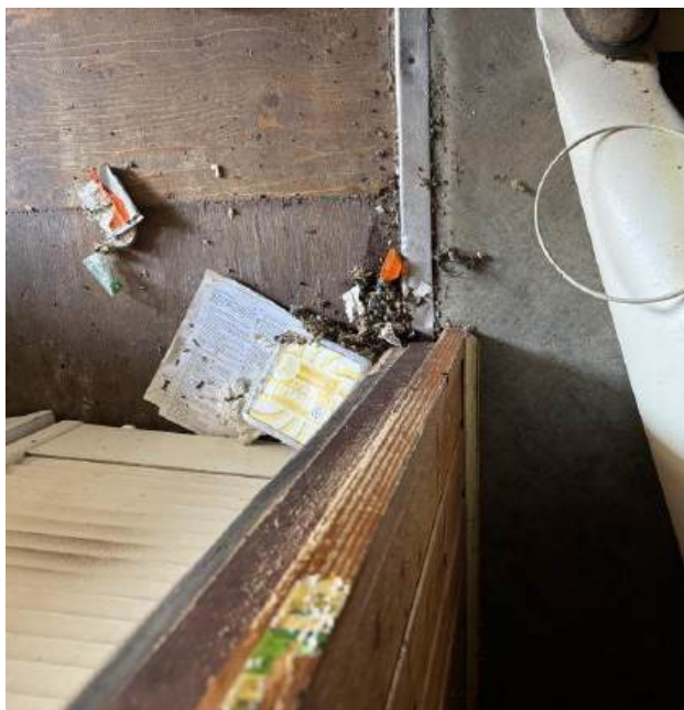
Foto 162 vloerzeil niet verdacht
