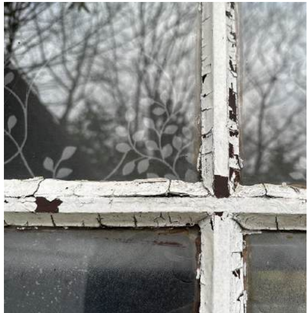
Foto 58 kit/ stopverf asbestvrij zie M03 en M04
