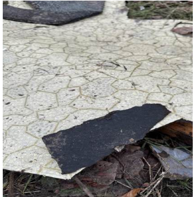
Foto 106 zeil asbestvrij, zwart vilt onderzijde, terrein A
