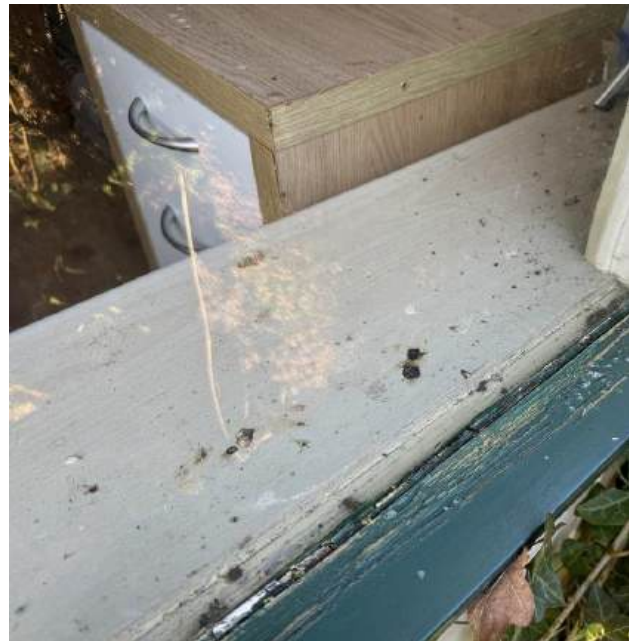
Foto 215 kit asbestvrij zie M10 en M11
