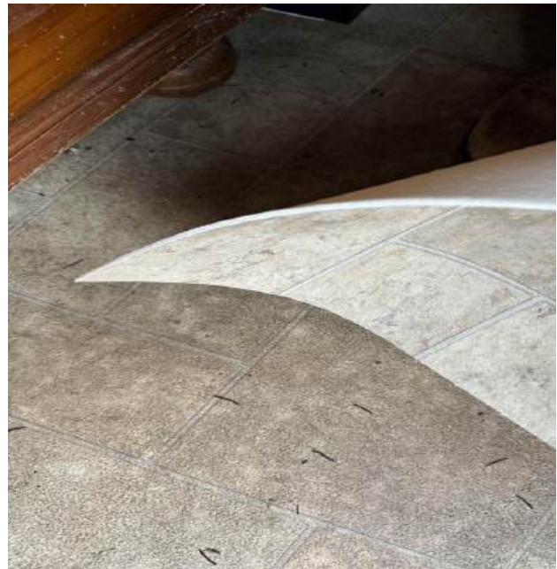
Foto 253 zeil vloer nr. 204 asbestvrij
