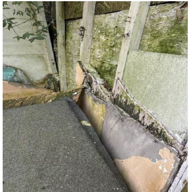
Foto 108 board asbestvrij zie M01 en M02
