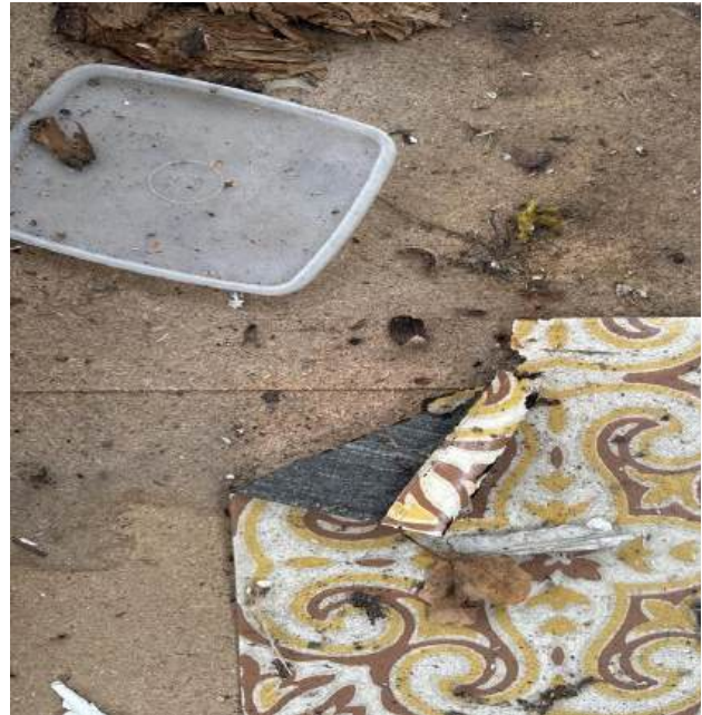
Foto 102 zeil niet verdacht, vilt onderzijde (zwart of donkerrood)
