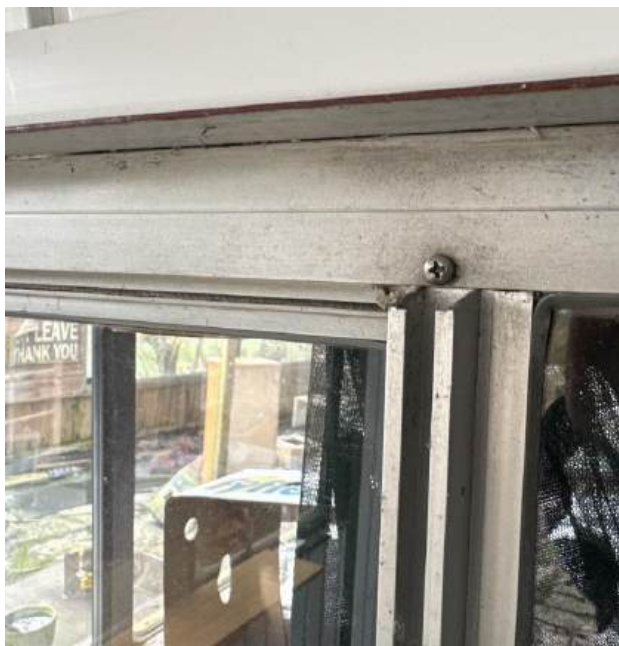
Foto 49 aluminium met rubber afdichting
