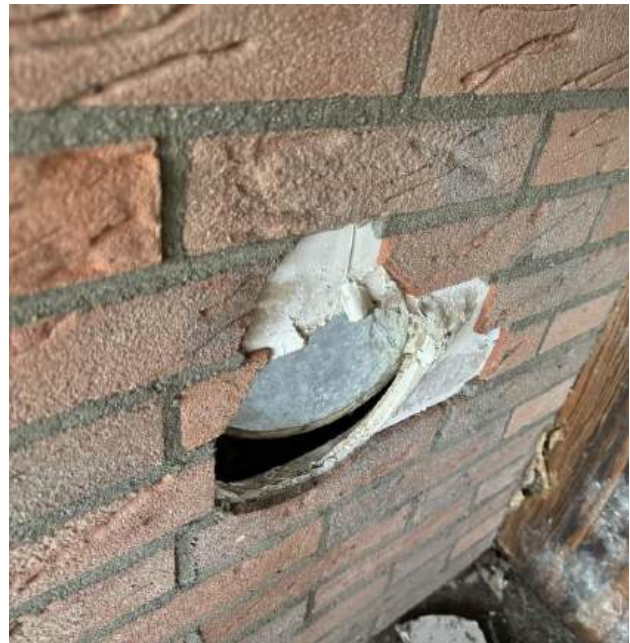
Foto 233, wand bij doorvoer nr. 181 van gipsplaat en steenstrips
