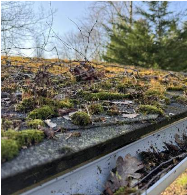
Foto 179 dak asbestvrij zie M07 nr. 149
