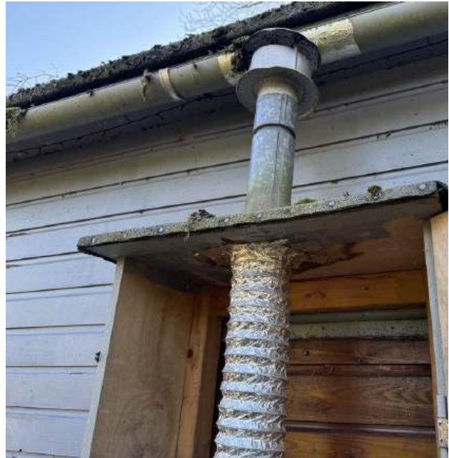
Foto 168 afvoer niet verdacht
