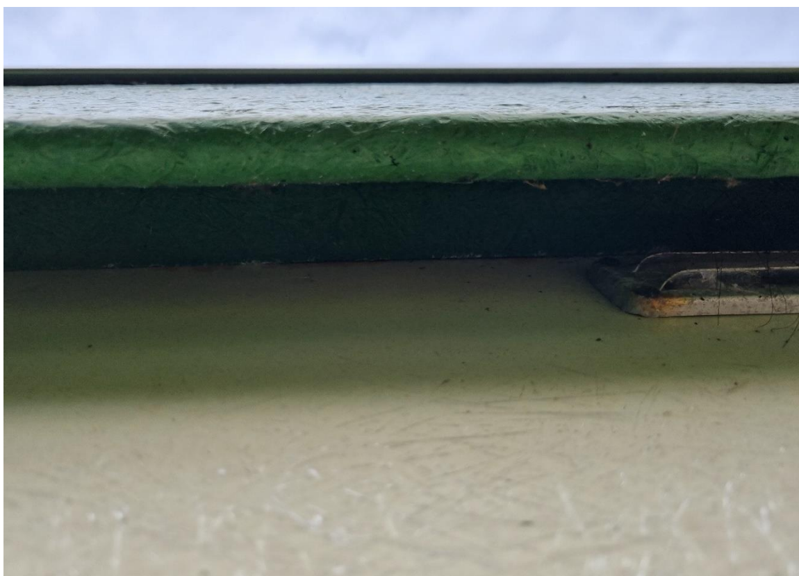
Figuur 22 Dichte afwerking bij de dakconstructies van één van de toiletgebouwen, zonder invliegopeningen voor vleermuizen.
