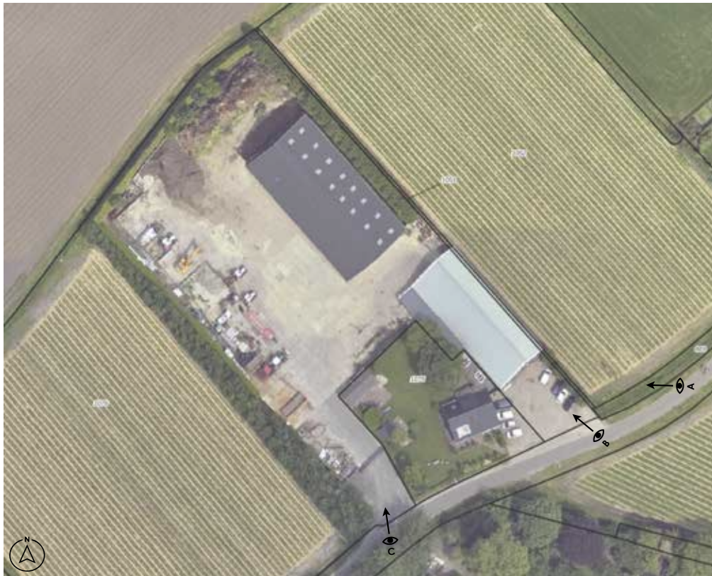
Satellietfoto van de bestaande situatie
