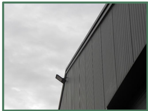
Foto 12: gesloten kopgevel van de loods.
