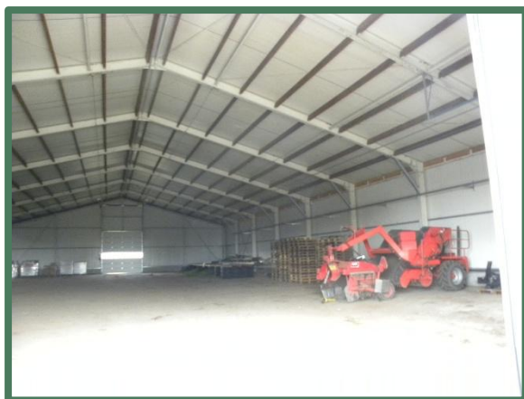
Foto 10: Binnenzijde zuidelijk gelegen loods.
