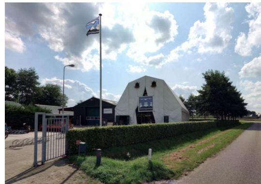
Afbeelding: Corsobouwplaats. (bron: www.cyclomedia.com )
