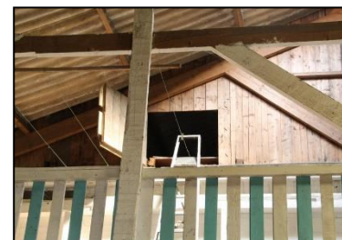
Figuur 11. Het luik dat toegang geeft tot de vloering.
