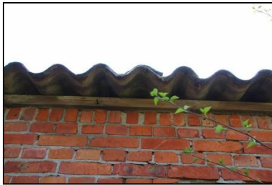
Figuur 17. Ruimte onder de golfplaten, waardoor vleermuizen naar binnen kunnen.
