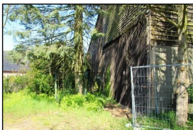
Figuur 7. De zuidzijde van de onderzoekslocatie, kijkrichting naar het westen.
