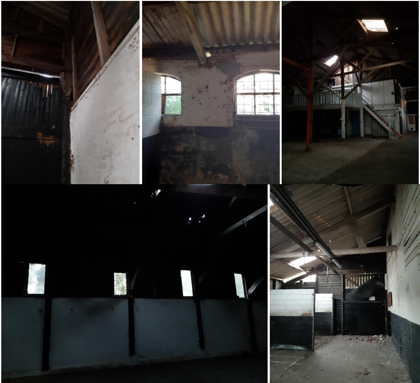
Foto-impressie vervolg. Een verscheidenheid aan openingen binnen de te slopen bebouwing, zoals gaten in de muur en in het dak.
