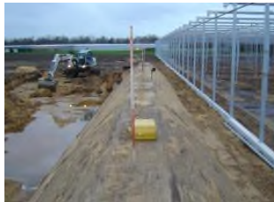
grondwerk tbv kassenbouw
