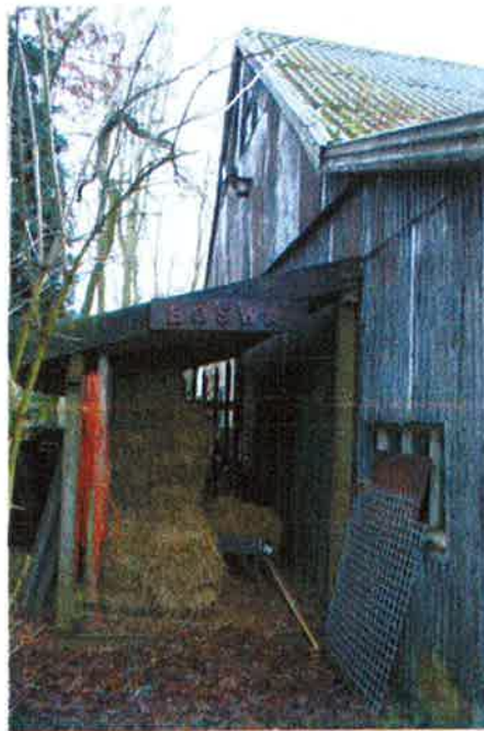
Achtergevel vanaf de rechterzijde
