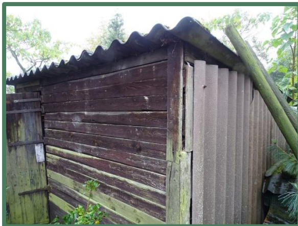
Overzicht te slopen schuurtje
