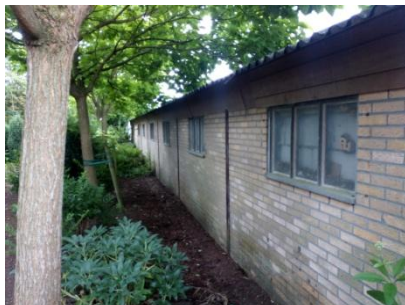
Noordoostelijke gevel van de werktuigenloods.
