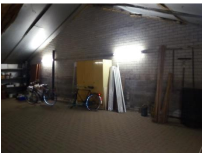
Scheidingswand tussen de privé bergingsruimte en de werktuigenopslagruimte.
