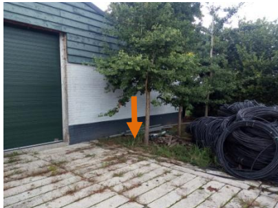
Aangewezen vml. locatie bovengrondse dieselolietank in een lekbak tegen de zuidoostgevel.
