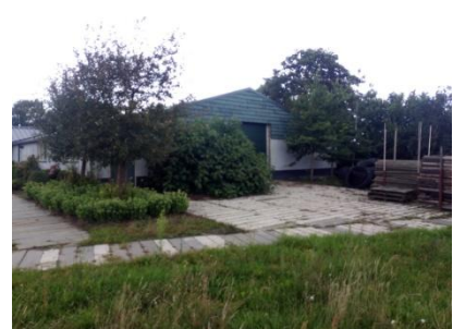
Zuidoostgevel van de wijnmakerijloods.
