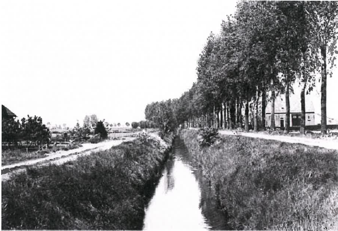
Turfvaart het Monnikenriool te Etten met aan weerszijden een trekpad en aan een kant daar achter een bomenrij. Zo hoort een vaartprofiel te zijn.
