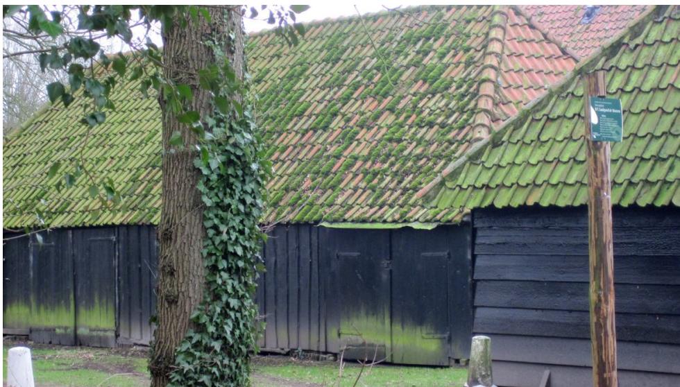
B13. Deze met zwartgeteerd houtbeklede oude schuren staan tegenover het Oude Huis aan de zuidzijde van de kruising Moersebaan en Grasdreef.
