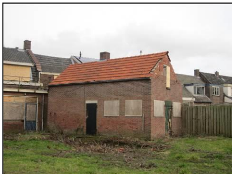
ongeschikt gemaakte schuur
