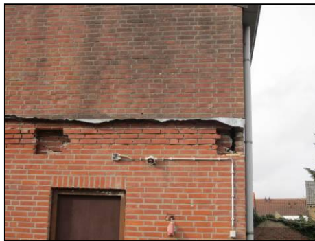
ongeschikt gemaakte loods
