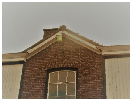
Voorgevel van achterste gebouw met geschikte invliegmogelijkheden voor gierzwaluw en vleermuizen
