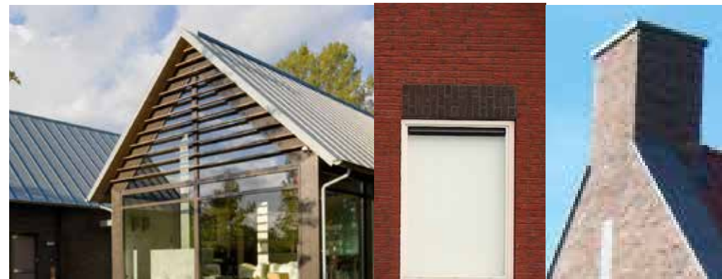
eenvoudige verbijzondering gevel, rechtlijnige vormgeving
