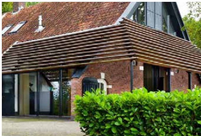
houten delen als uitbouw van het dak
