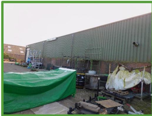
Uitzicht vanuit het noordwesten op te slopen loods
