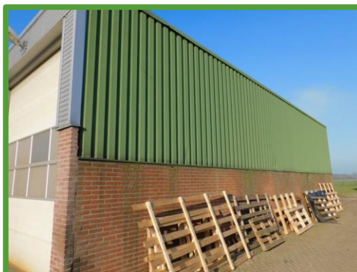
Uitzicht vanuit het oosten op de noordelijke te slopen loods
