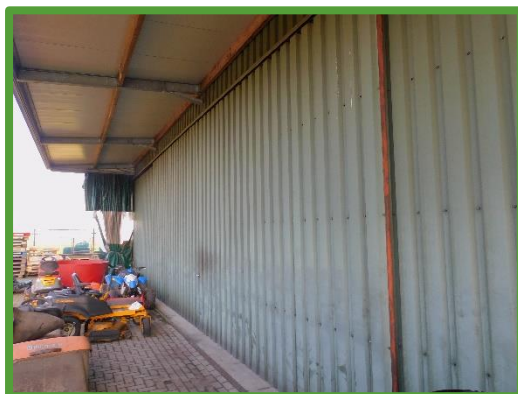
Afgesloten gevel te slopen loods
