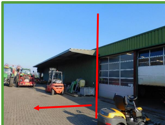
Zicht vanuit west op te slopen deel van de loods
