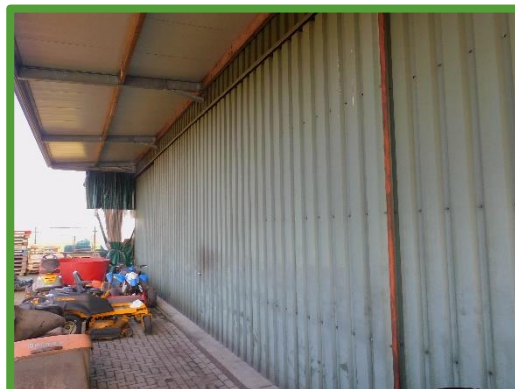
Achterzijde te slopen loods
