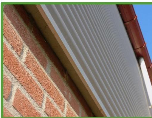
Afgesloten gevel te behouden loods
