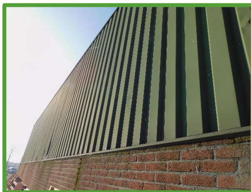
Afgesloten gevel te slopen loods
