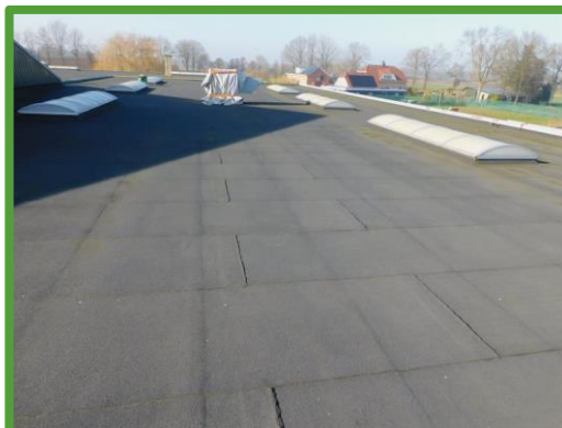
Dak van de noordelijke loods belegd met bitumen
