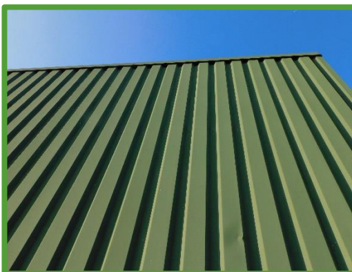
Afgesloten gevel te slopen loods
