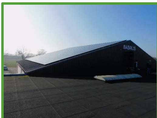
Dak met zicht op te behouden loods
