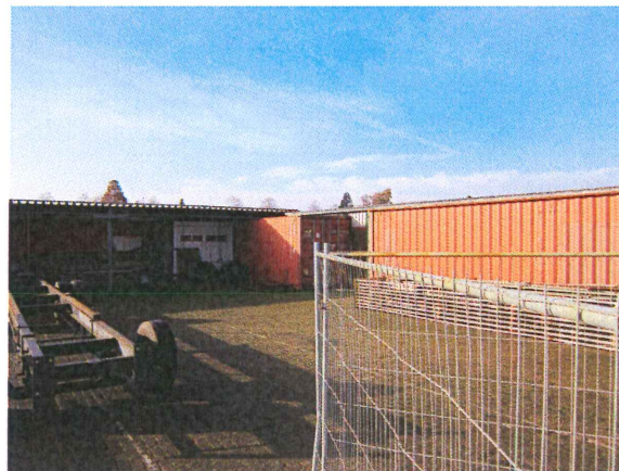
Fotonummer: 8 Omschrijving: Bouwplaats bloemencorso
